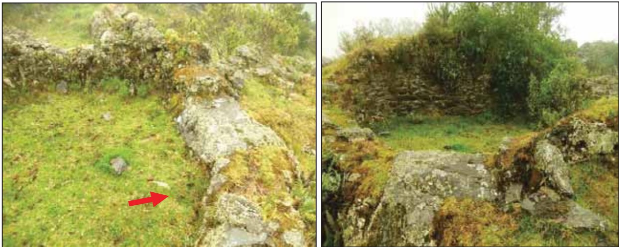
Figura 64: Vista lateral, se muestra el vano de acceso, aprovechando el afloramiento rocoso.
