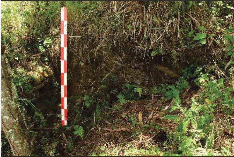
Figura 32: Vista frontal de la Estructura EP – 1
