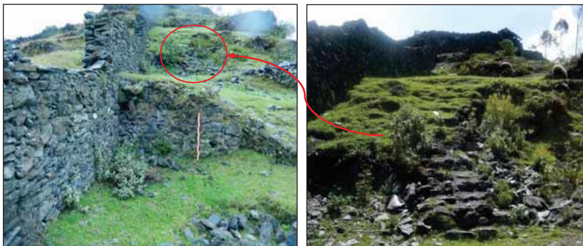
Figura 51: Escalinatas adecuadas a la topografía para comunicar niveles diferentes, ubicadas en el sector II, sub sector C.
