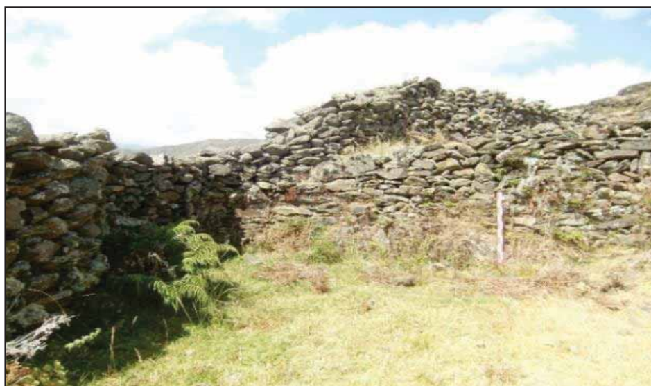
Figura 34: Vista frontal de la Estructura R-106.
