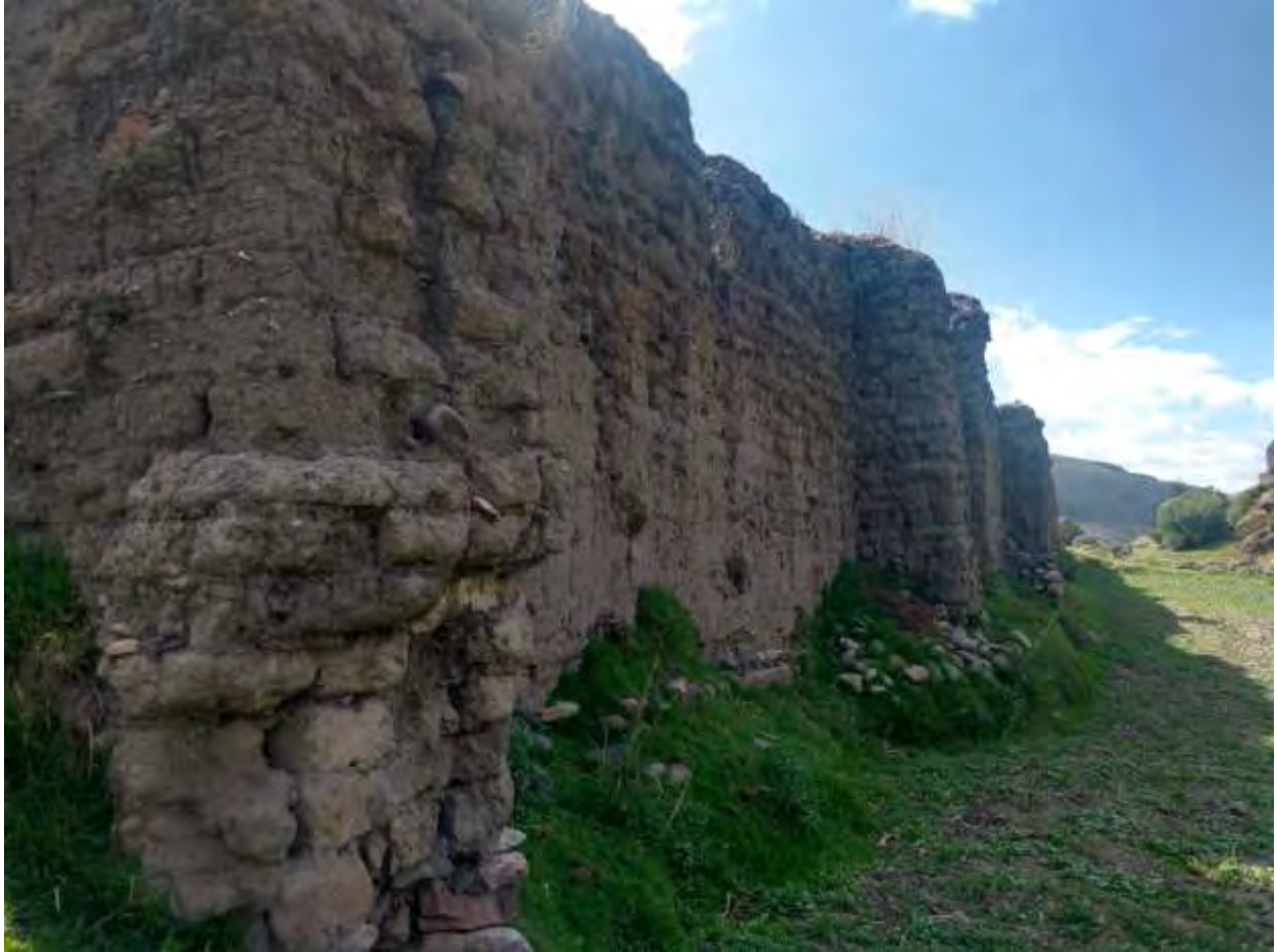
Muro de la capilla existente en el obraje. Foto: Acervo personal, 14 – 10 - 2018
