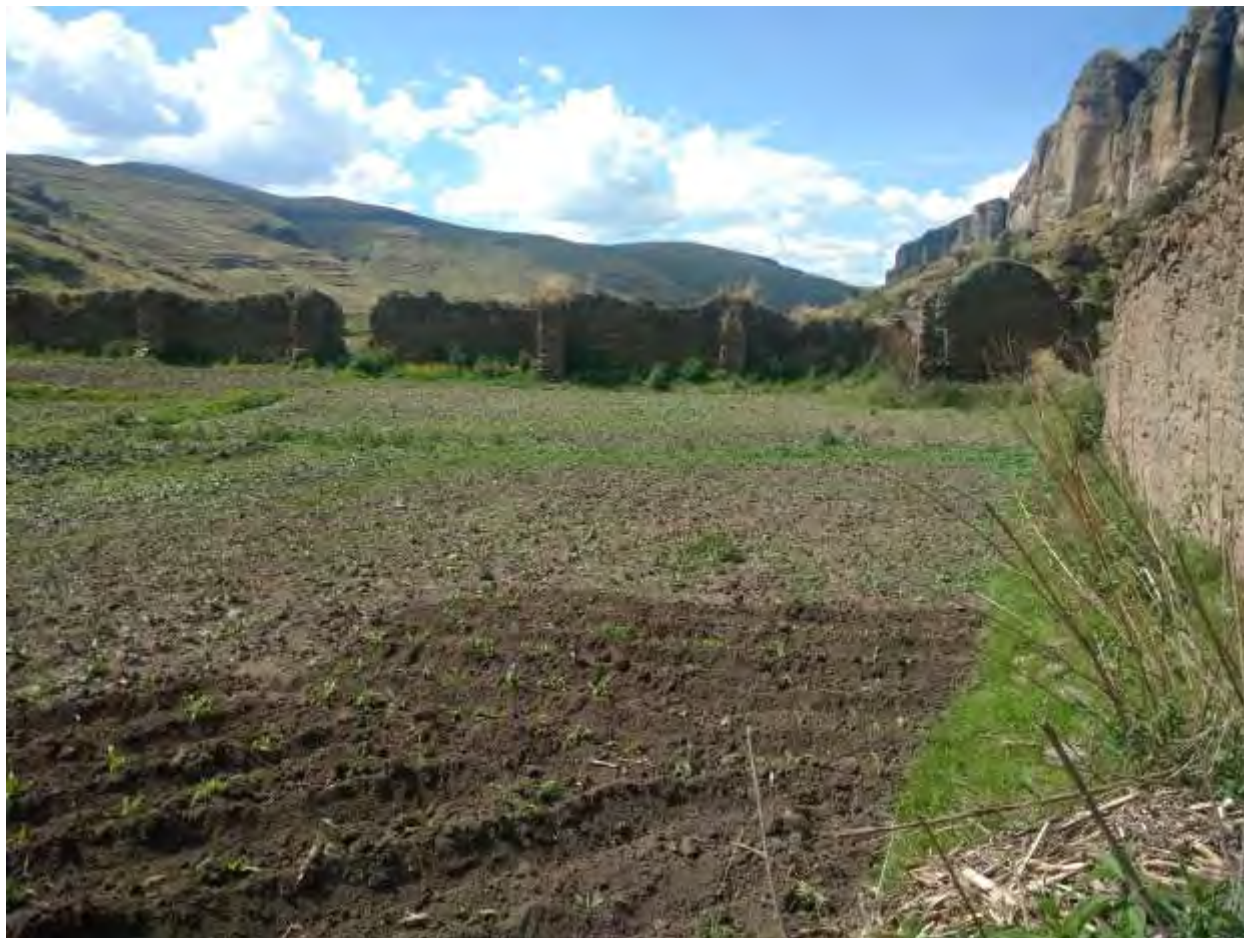
Muros del obraje. Fuente: Acervo personal.
