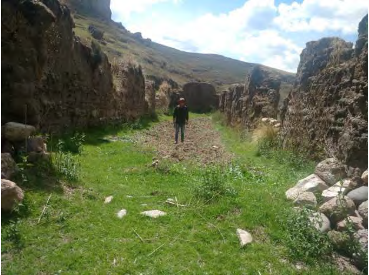
Una toma de parte interior de la construcción de la capilla
