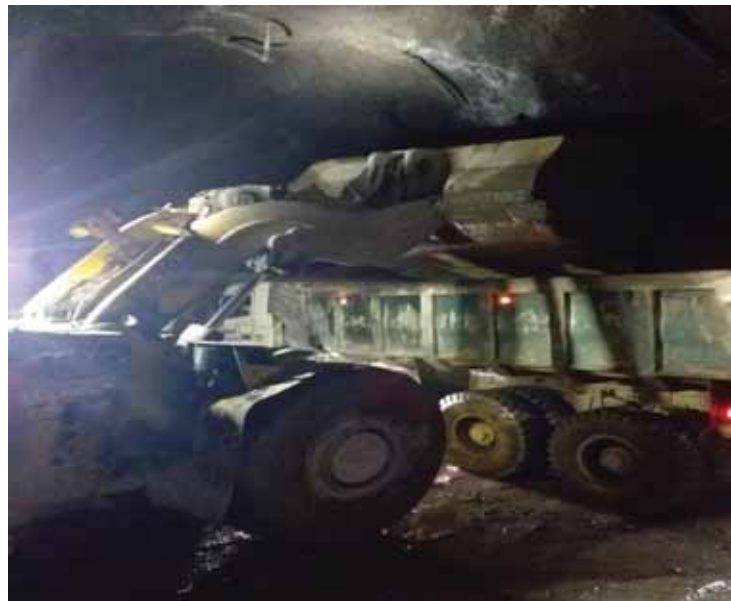
Ilustración 12. Muestra las operaciones de carguío y acarreo (volvo). Fuente: Área de Operaciones mina San Cristóbal
