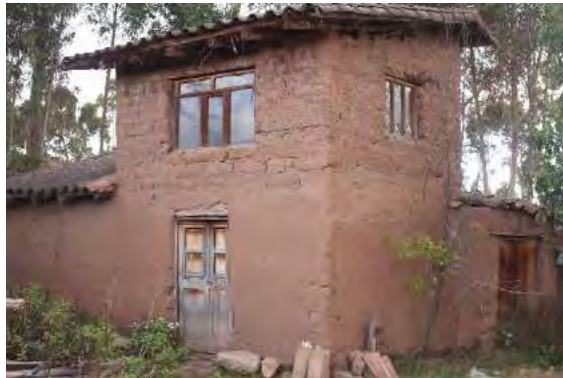
Figura 3.45. Foto y plano de vivienda encuestada N°11, donde se aprecia el tipo de techo de una caída. Fuente: Elaboración propia, 2019.
