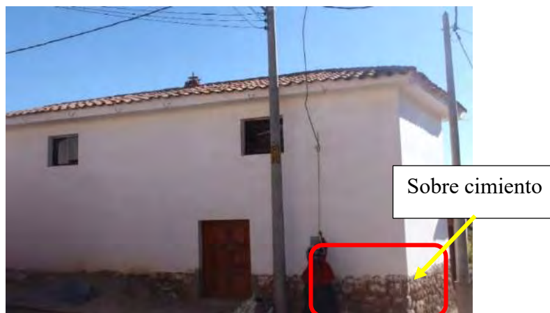
Figura 2.31. Sobre cimiento de piedra, vivienda ubicada cerca de la zona arqueológica de Chinchero. Fuente: Elaboración propia, 2019.
