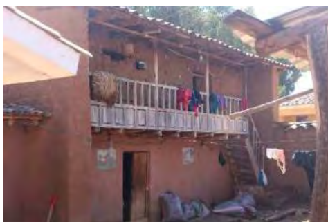
Figura 4.2. Edificación con contrafuertes en las esquinas. Fuente: Elaboración propia, 2019.
