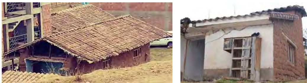
Figura 3.43. A la derecha tipo de techo de dos caídas, a la izquierda tipo de techo de una caída. Fuente: Elaboración propia, 2019.
