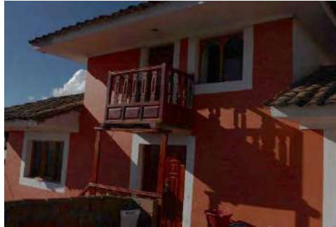
Figura 4.19 Elemento no estructural anclado al entrepiso. Fuente: Elaboración propia, 2019.
