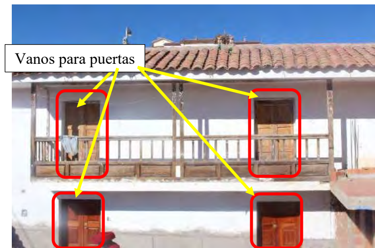
Figura 2.26 Presencia de vanos uniformemente distribuidos a lo largo del muro de la vivienda. Fuente: Elaboración propia, 2019.
