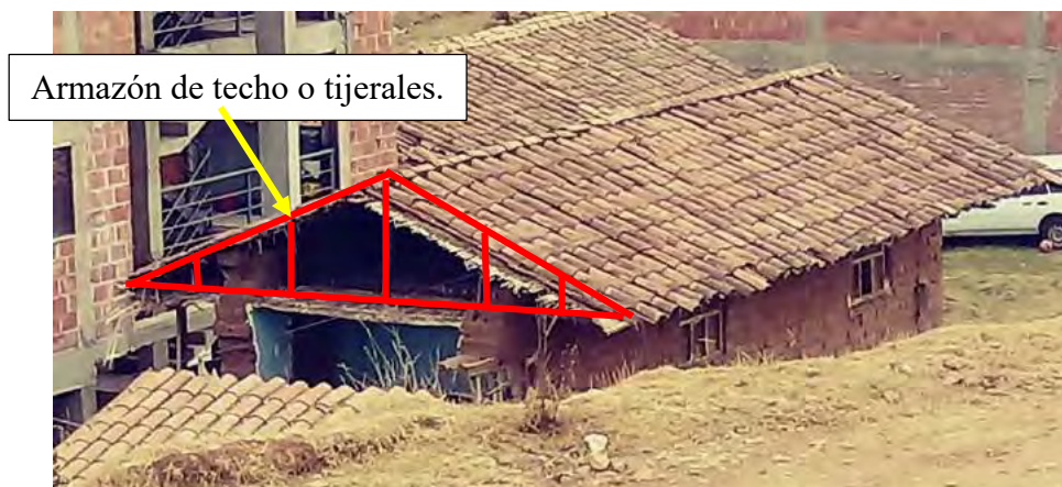
Figura 2.28. Vista del armazón de techo en viviendas de adobe. Fuente: Elaboración propia, 2019.
