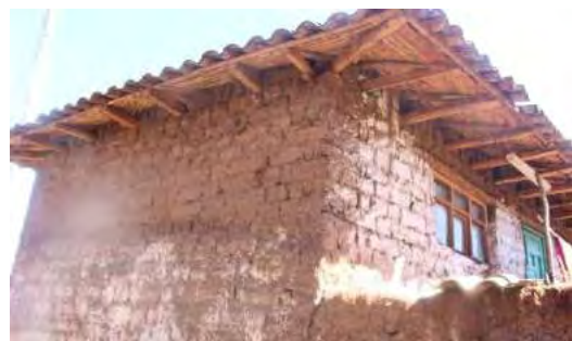
Figura 4.3. Edificación sin arriostre horizontal y vertical, ni contrafuertes, cuenta con muros ortogonales bien trabados. Fuente: Elaboración propia, 2019.
