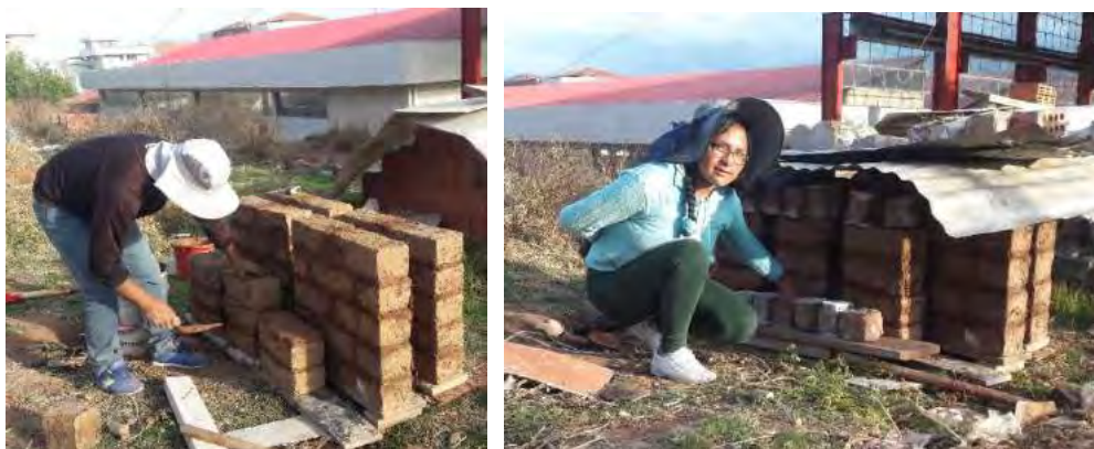
Figura 3.30 Construcción de los muretes de adobe para los ensayos de compresión diagonal. Fuente: Elaboración propia, 2019.
