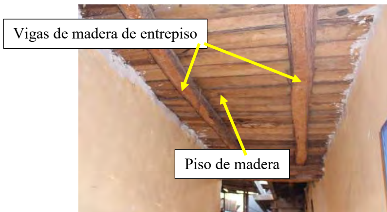
Figura 2.27. Vista del entrepiso, de una vivienda de adobe. Fuente: Elaboración propia, 2019.
