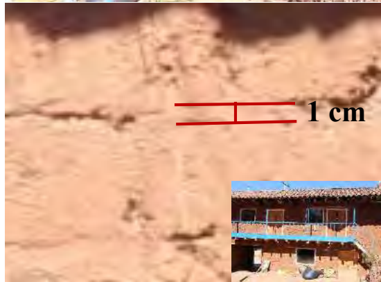
Figura 4.6. Ancho de mortero de la vivienda encuestada n° 06. Fuente: Elaboración propia, 2019.
