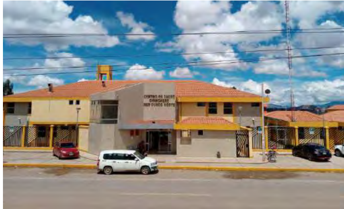
Figura 3.12 Edificaciones institucionales de concreto armado, sistema aporticado
