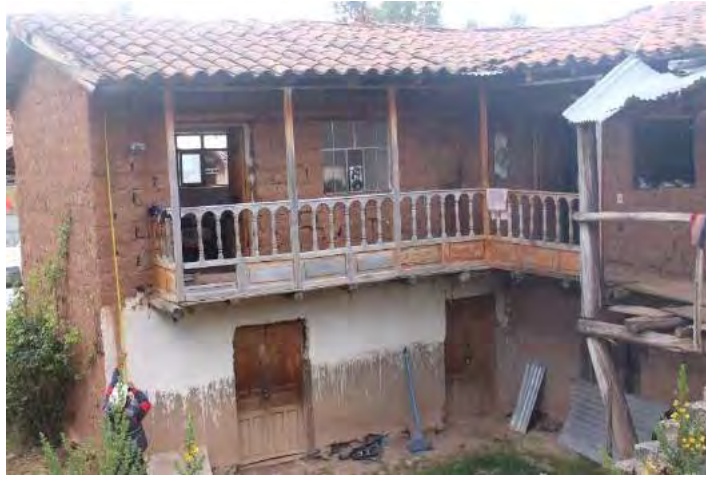
Figura 2.30. Balcón corrido, en el patio de vivienda. Fuente: Elaboración propia, 2019.
