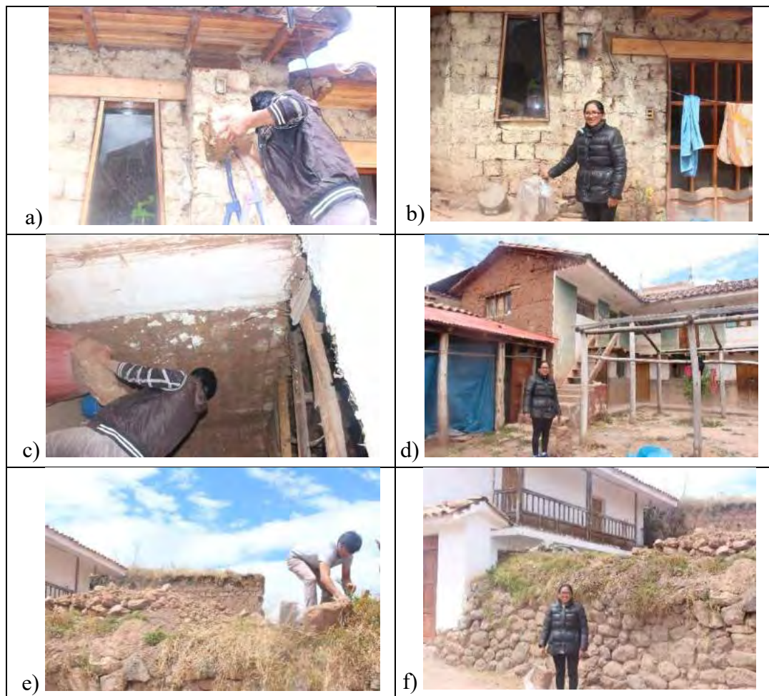
Figura 3.19. Muestras de adobe extraídas de las tres viviendas. a) Muestra de adobe 01, extraída de la vivienda encuestada N° 13, año de fabricación: 2002, b) Acondicionamiento de la muestra de adobe n° 01, c) Muestra de adobe 02, extraída de la vivienda encuestada N° 04, año de fabricación: 1992, d) Acondicionamiento de la muestra de adobe n° 02, e) Muestra de adobe 03, Extraída de la vivienda encuestada N° 18, año de fabricación: 1978, f) Acondicionamiento de la muestra de adobe n° 03. Fuente: Elaboración propia, 2019.
