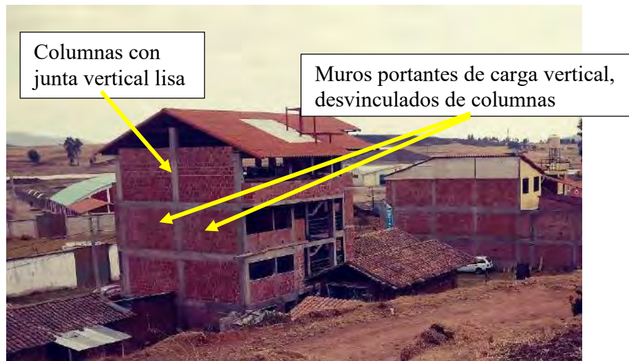
Figura 3.10 Sistema híbrido de construcción entre albañilería confinada y sistema aporticado. Fuente: propia, 2019.
