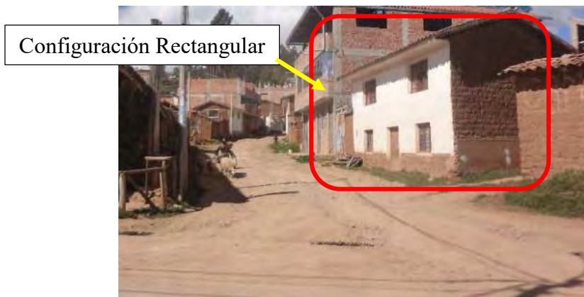
Figura 2.33 Configuración típica de viviendas de adobe en la zona urbana de Chinchero. Fuente: Elaboración propia, 2019.
