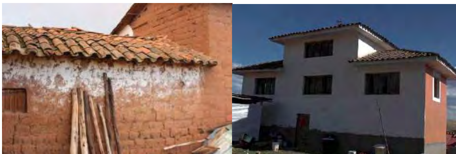
Figura 4.14 Edificaciones de dos y tres pisos que presentan irregularidad en elevación. Fuente: Elaboración propia, 2019.
