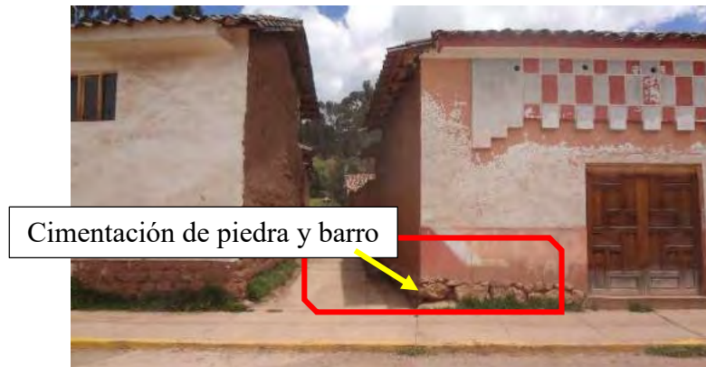
Figura 2.25 Cimiento de una vivienda de adobe, donde se observa que sobresale del terreno natural. Fuente: Elaboración propia, 2019.
