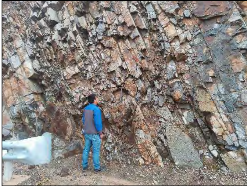
Foto 28 Fracturas en el Macizo rocoso de cuarzo diorita de hornblenda
