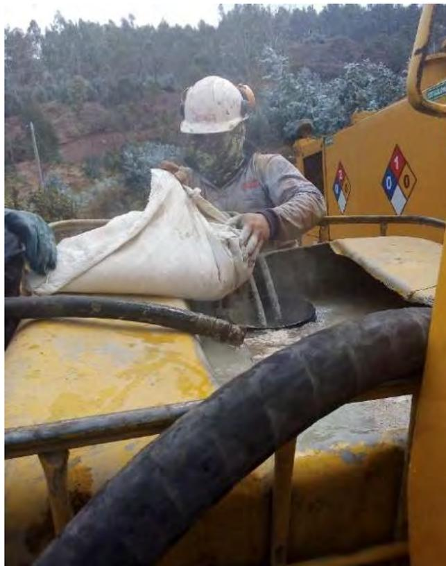
*Foto N° 10.3 Preparación Del Lodo De Perforación*
