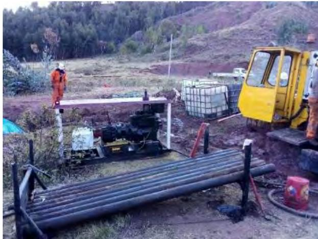
Foto N° 1.5 Perforación por el método de rotopercusión
