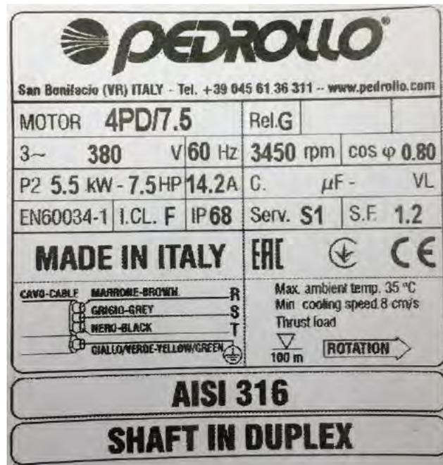
*Foto N° 10.5 Especificaciones técnicas de la bomba instalada*
