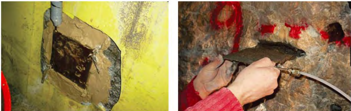
Celda de presión radial
