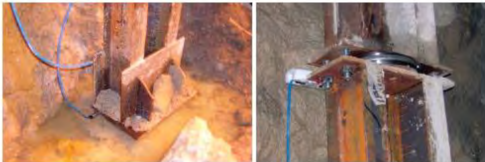
Fotografía N° 9 Instalación de celdas de carga
