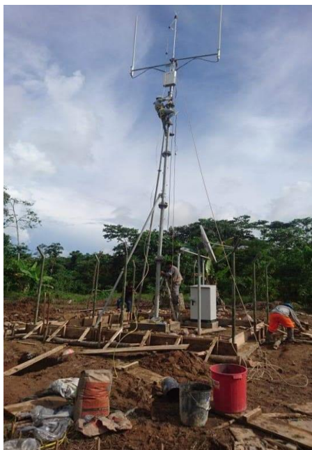
Fotografía 8. Instalación de las primeras antenas telefónicas en las diferentes CC.NN (Fotografía: Municipalidad distrital de Megantoni)
