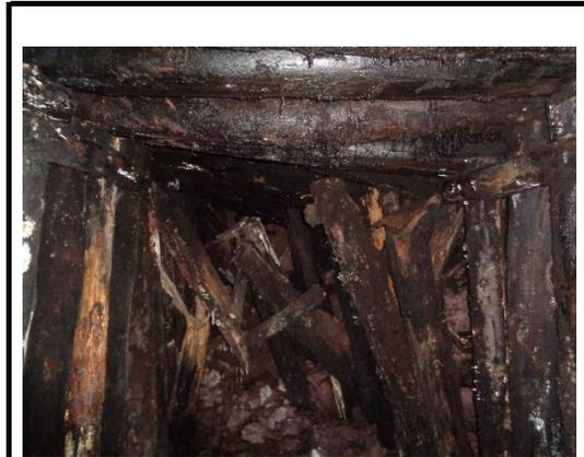
FOTO 6: Estructura de eucalipto en mal estado en galería filtrante
