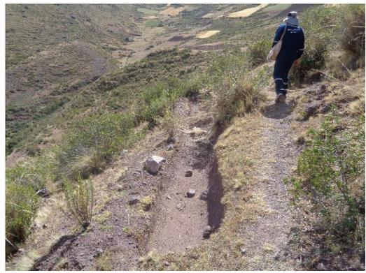
FOTO 2: Zanjas de Infiltración sin mantenimiento
