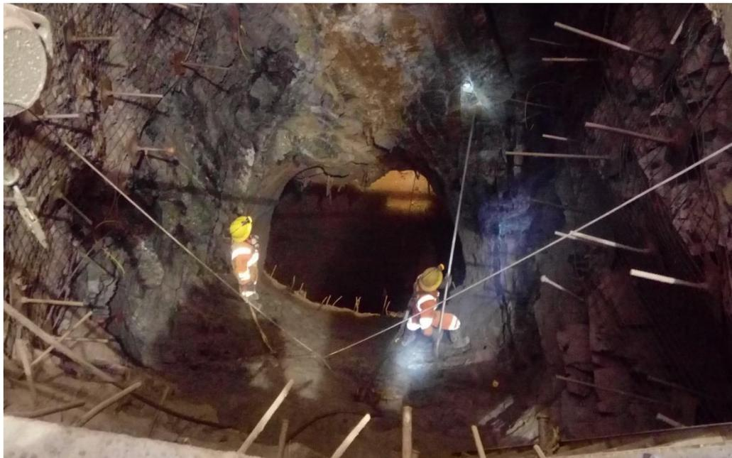
Figura 37: *Excavación y desquinche de bolsillos de mineral y desmonte*
