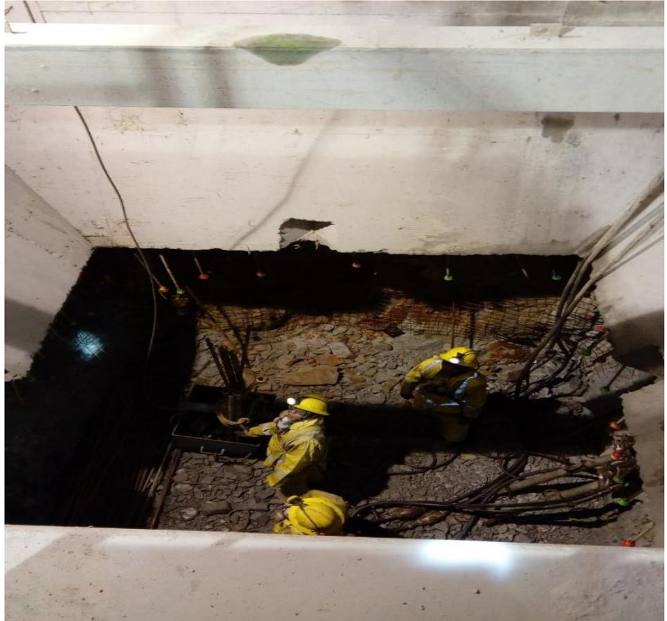
Figura 19: *extracción de material estéril mediante grúa batible del bolsillo*
