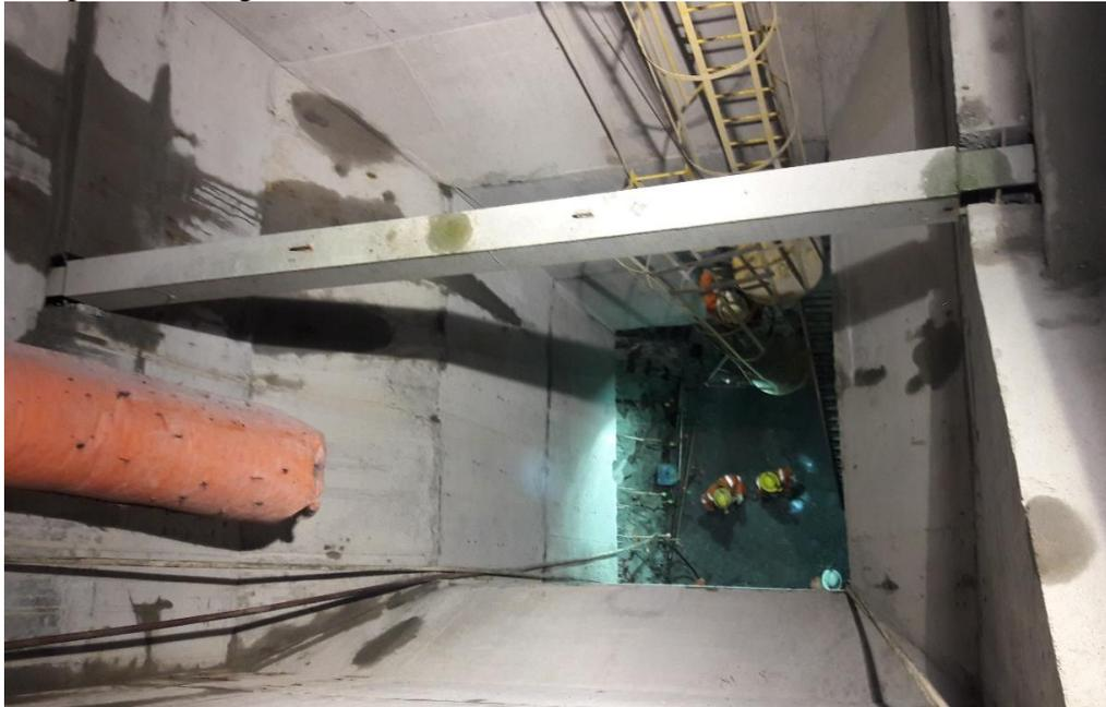
Figura 43: instalación de la viga H y planchas anti desgaste
