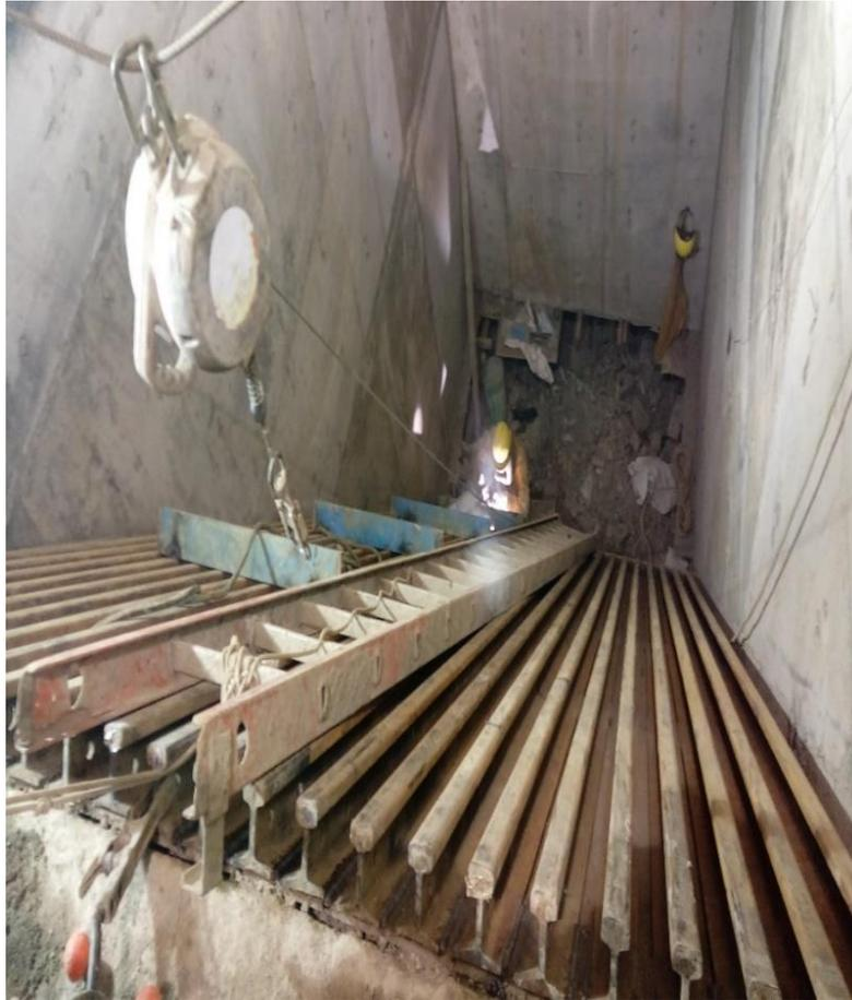
Figura 47: *Vaciado de concreto en la base de los bolsillos y colocación de rieles para evitar el desgaste del concreto*
