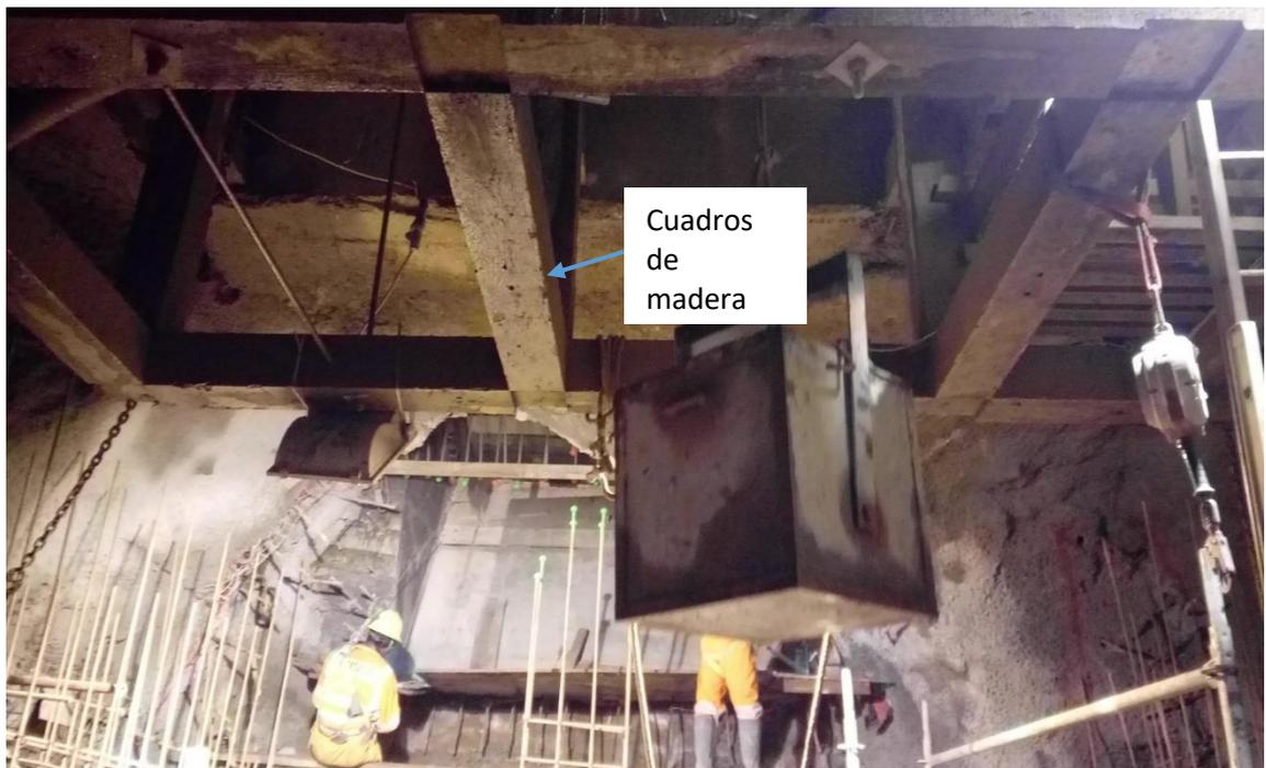
Figura 50: montaje de cuadros de madera en el loading pocket
