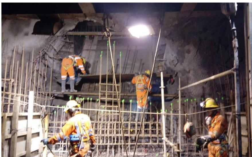
Figura 56: encofrado para el montaje de dosificadores
