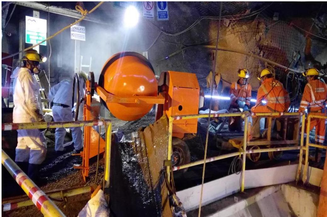
Figura 44: vaciado de los bolsillos con concreto utilizando mezclador de concreto
