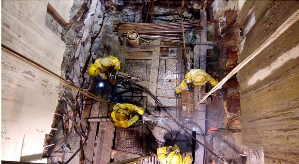
Figura 15: *ejecución del pique a plena sección usando el blasting set*
