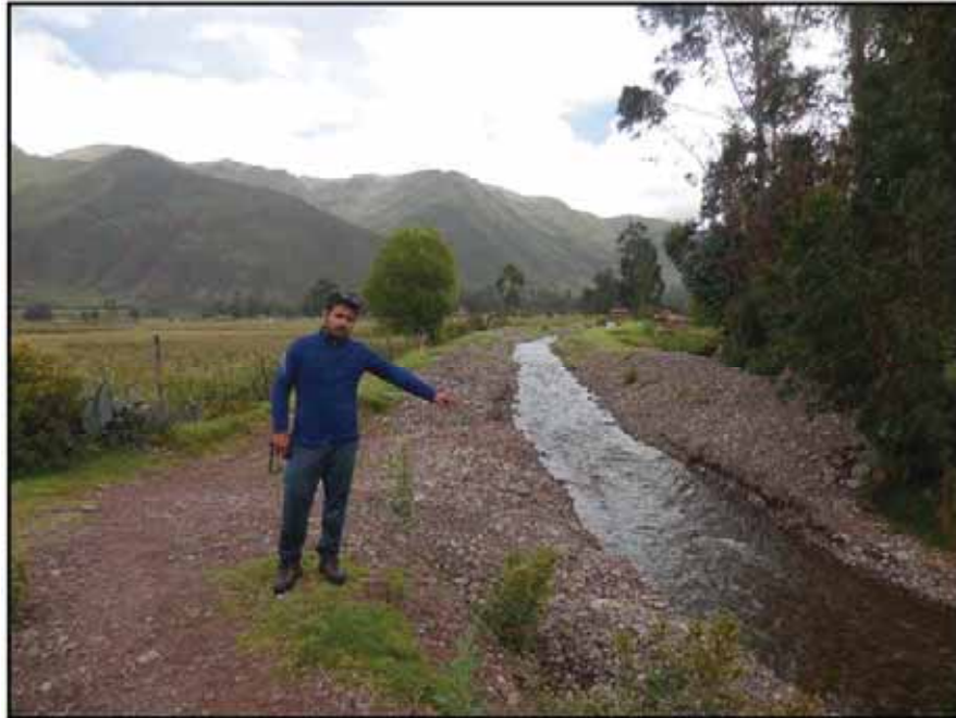
FOTOGRAFIA N°2. 3 TRAMO DEL RIO SIN PROTECCION EL LAS MARGENES.
