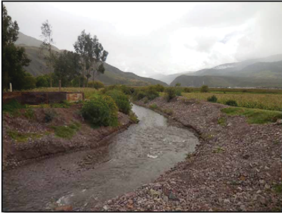
FOTOGRAFIA N°2. 6TRAMO DEL RIO SIN PROTECCION ANTE INUNDACIONES.
