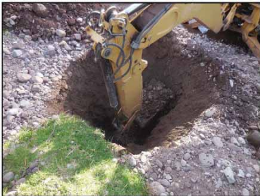
Fotografía N° 7. 3 calicata 02 a -1.00 m.
