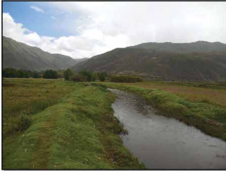
FOTOGRAFIA N°2. 4 TRAMO FINAL DEL RIO SIN DEFENSA.
