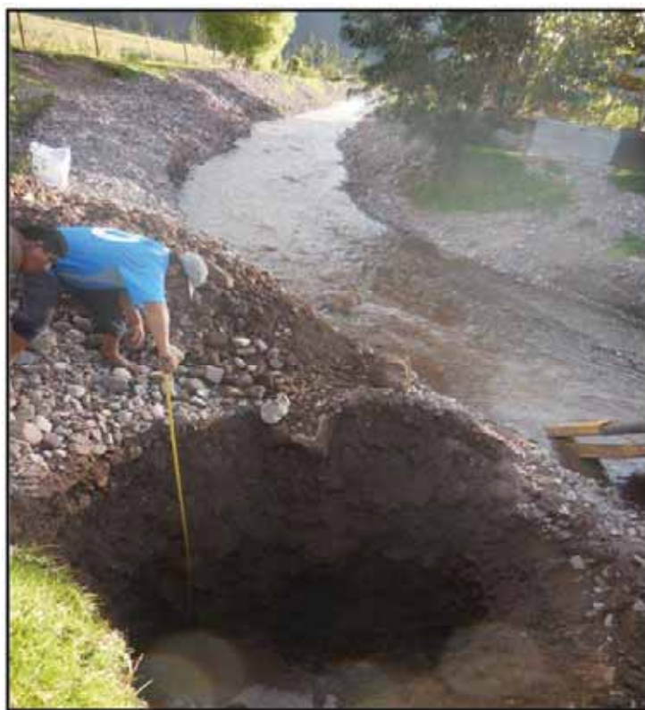
Fotografía N° 7. 4 Medición de las alturas se observa el nivel freático a -2.3m.
