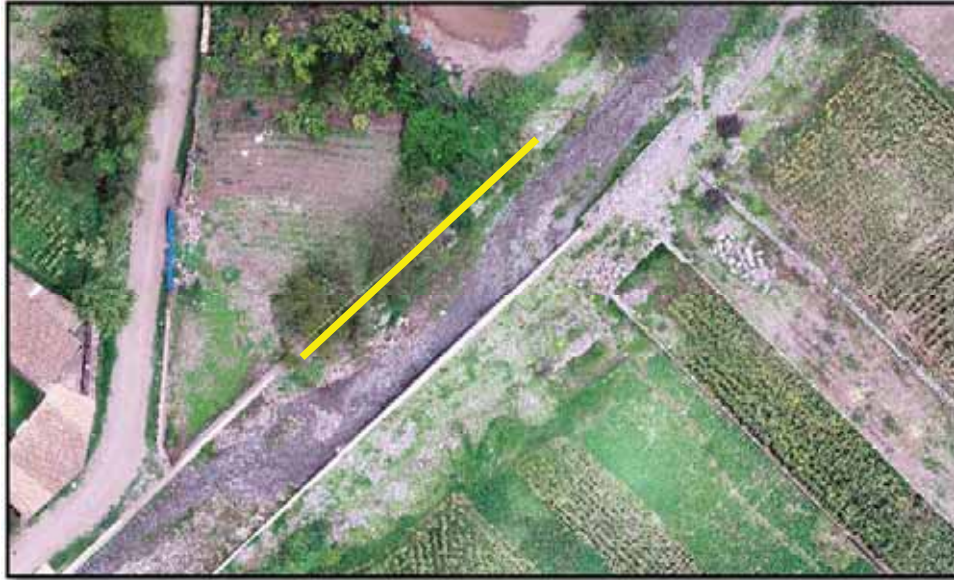
FOTOGRAFIA N°2. 2 MURO DE CONCRETO ARMADO L=34.00m.
