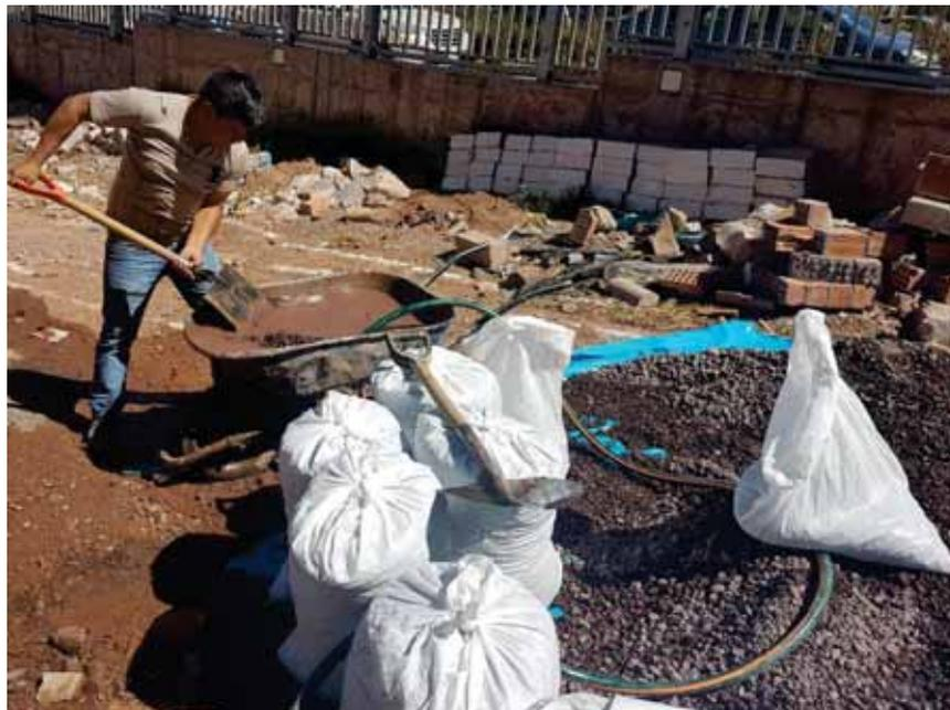
*Figura 9.* Lavado y ensaquillado del agregado grueso para luego ser secado y almacenado
