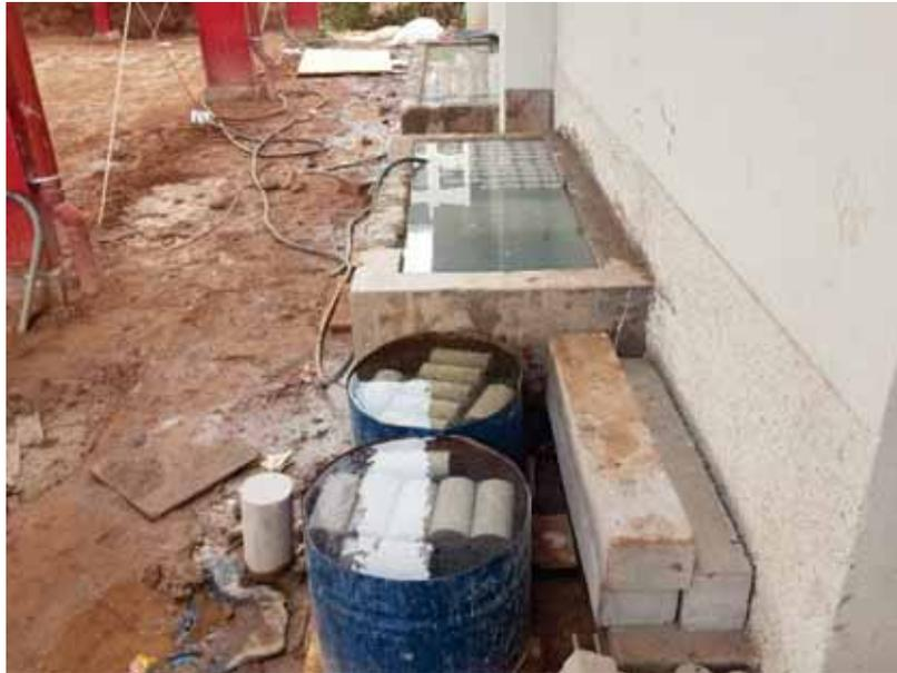
**Figura 42.** Curado del concreto por inmersión
