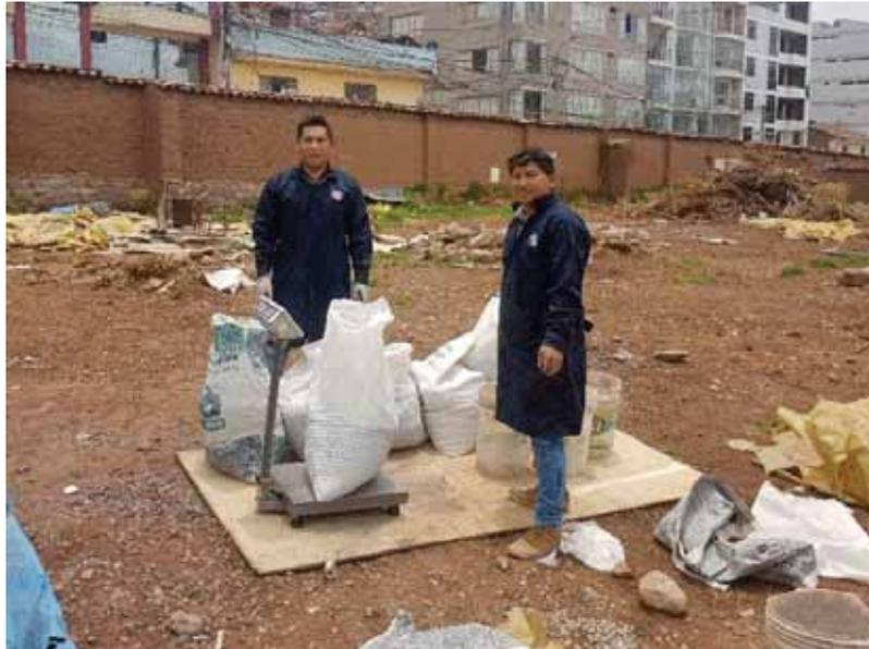
**Figura 37.** Pesado de los materiales por tanda, de acuerdo al diseño de mezcla
