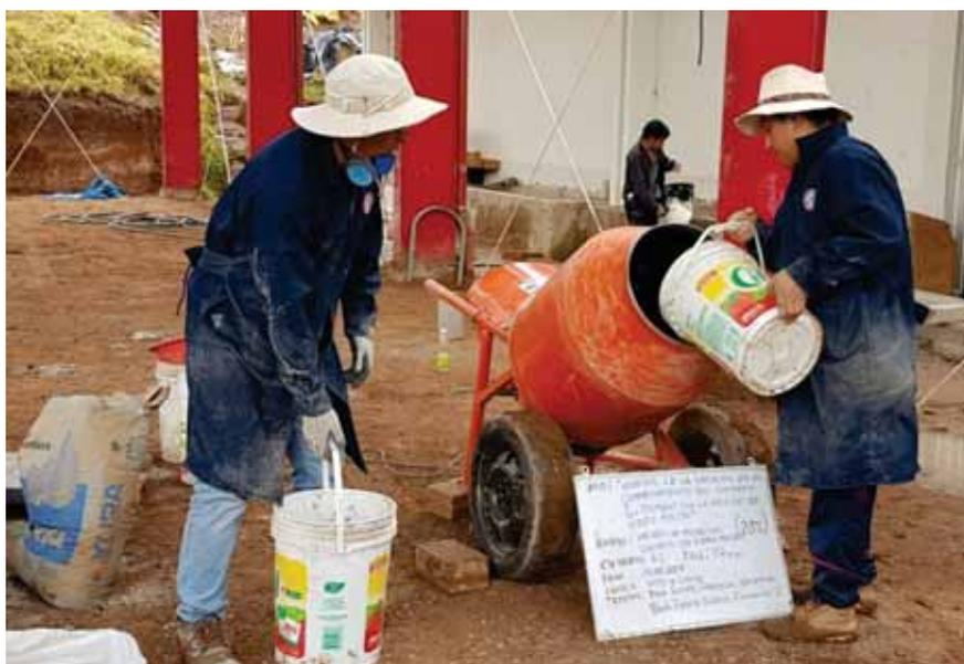
**Figura 38.** Proceso de mezclado de los materiales del concreto
