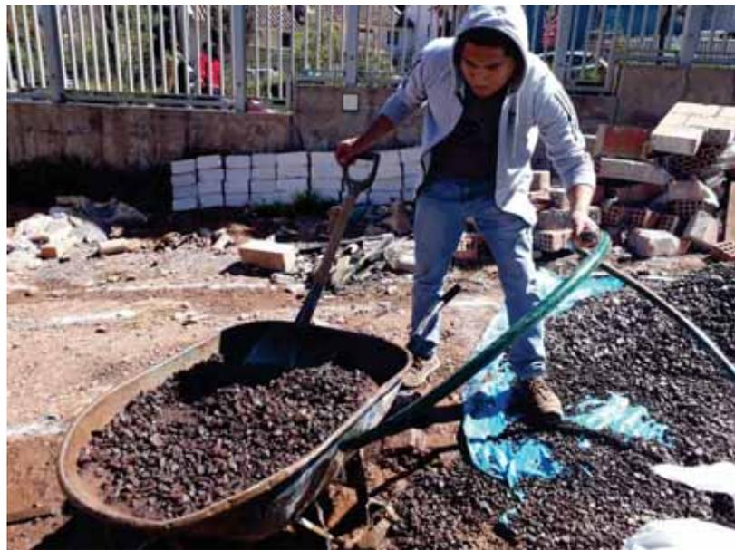
*Figura 32.* Lavado del agregado grueso de vicho
