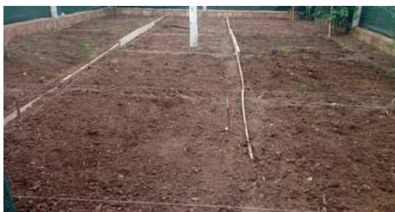
Foto N° 8. Preparación del terreno y armado de las parcelas
