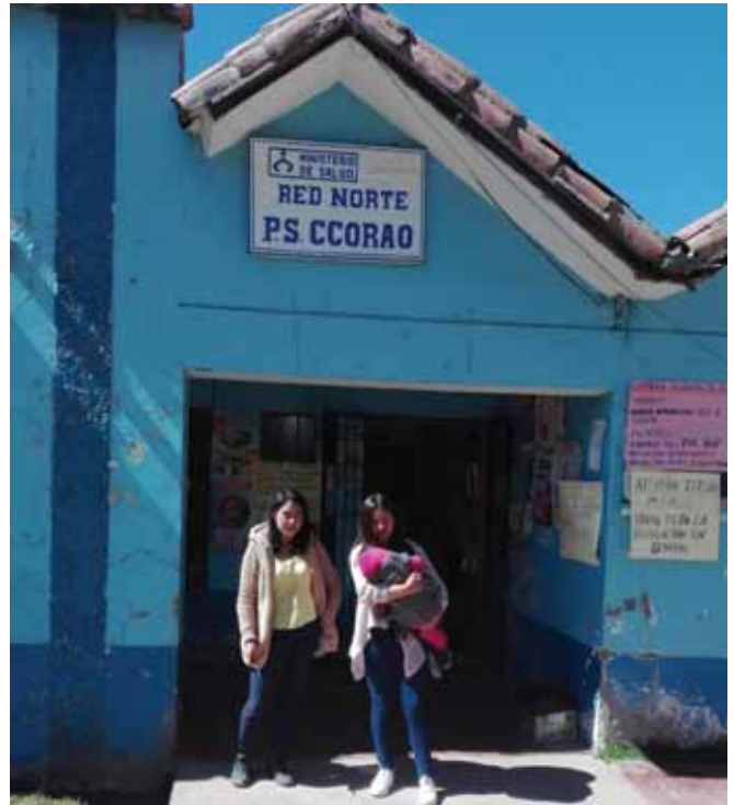
Fotografía 6. Fachada del puesto de salud de Ccorao
