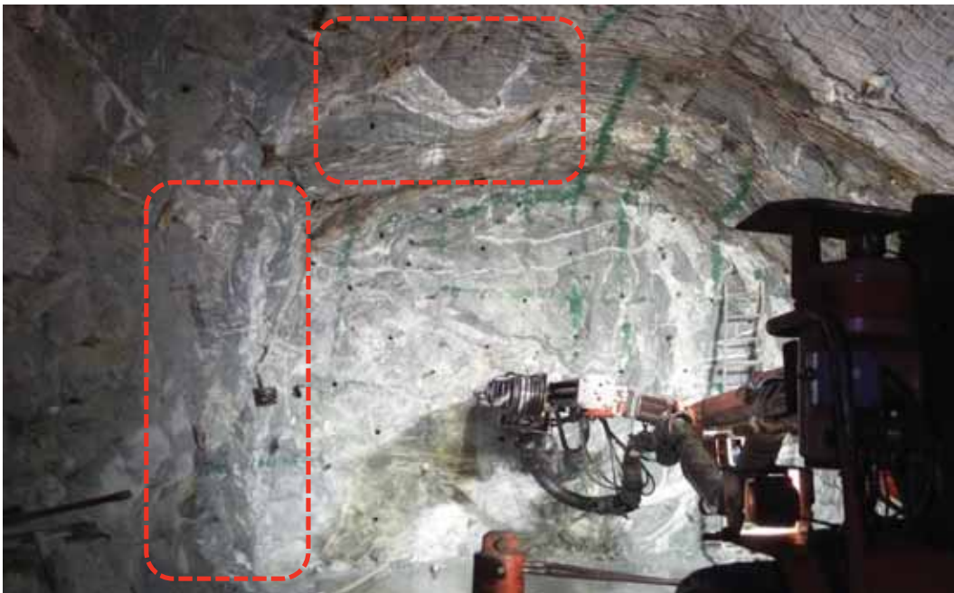
Imagen 26: Pintado de malla de perforación y proyección de colas en corona
