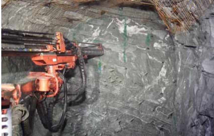
Imagen 27: Perforación de frente sin el uso de guidores
