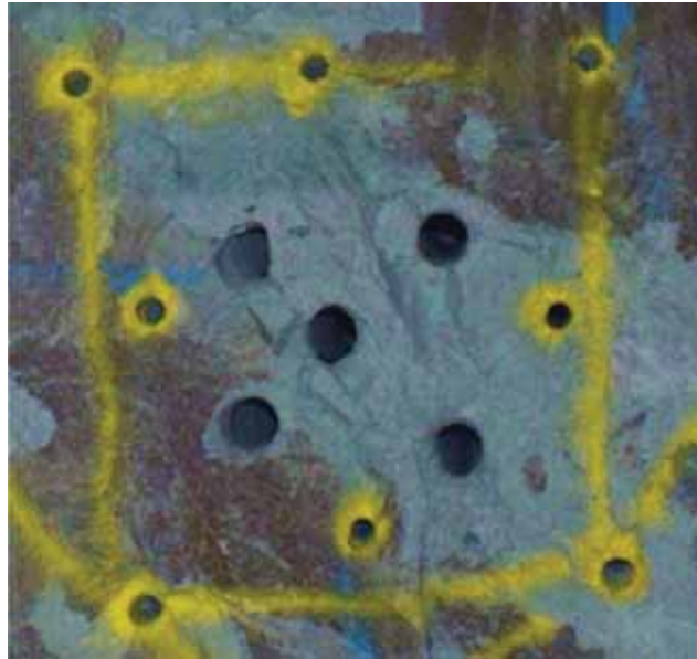
Imagen 25: Arranque de la malla de perforación realizada por los perforistas
