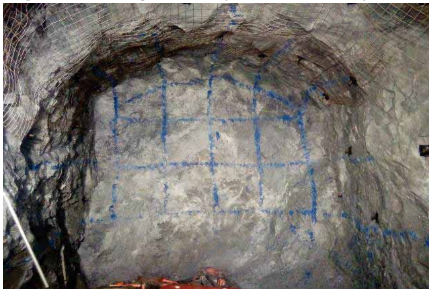
Imagen 47: Malla de perforación y colas en la corona y hastiales
