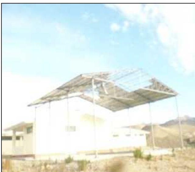
TECHO DEL GALPON DE VEHICULOS CON 60% MAL ESTADO POR EFECTO DE VIENTOS
