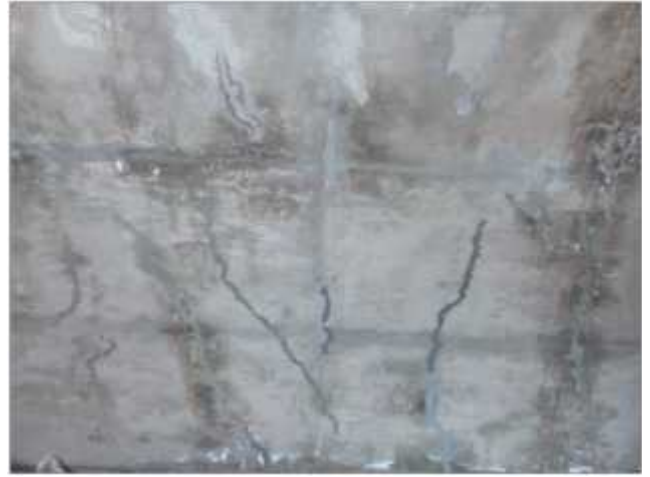
INTERIOR DE LOS POLVORINES CON FISURAS Y HUMEDAD POR FILTRACIONES
