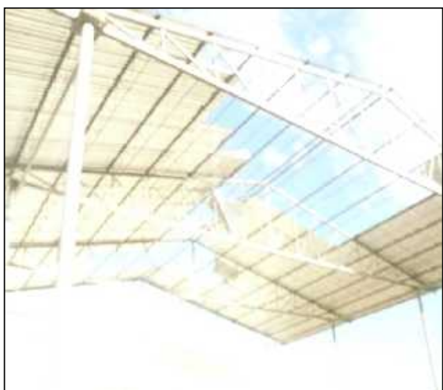
TECHO DEL GALPON DE VEHICULOS CON 60% MAL ESTADO POR EFECTO DE VIENTOS
