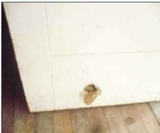
FRAGILIDAD DE PUERTAS Y MUROS – USO DE MATERIAL NO IDÓNEO PARA LA ZONA
