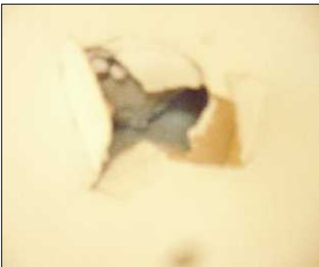
FRAGILIDAD DE PUERTAS Y MUROS – USO DE MATERIAL NO IDÓNEO PARA LA ZONA
