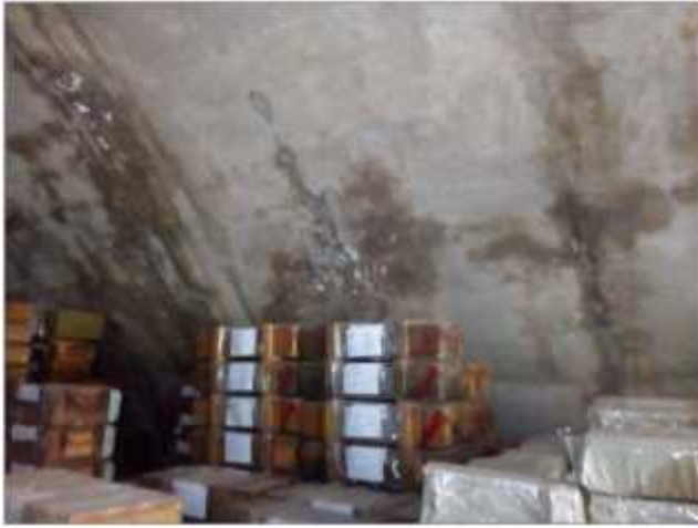
INTERIOR DE LOS POLVORINES CON FISURAS Y HUMEDAD POR FILTRACIONES
