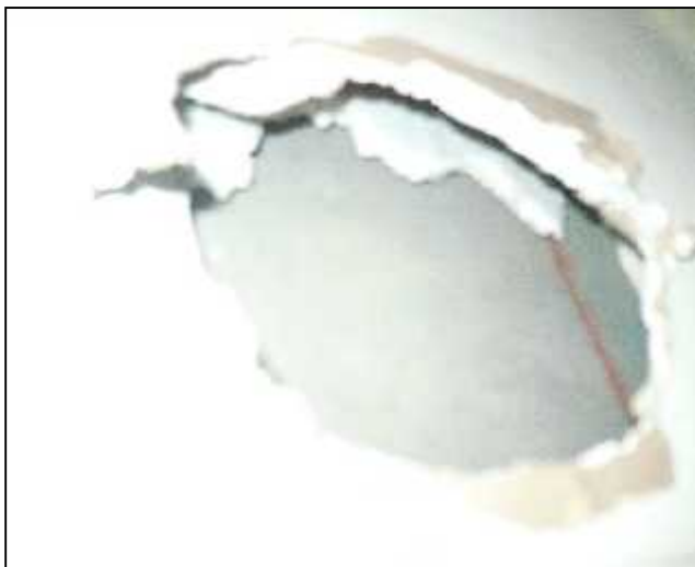
AISLAMIENTO ACUSTICO DE LAS PAREDES DETERIORADO
