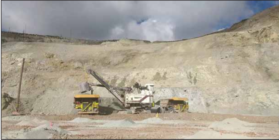
Figura N° 8: Carga de material a los camiones.
