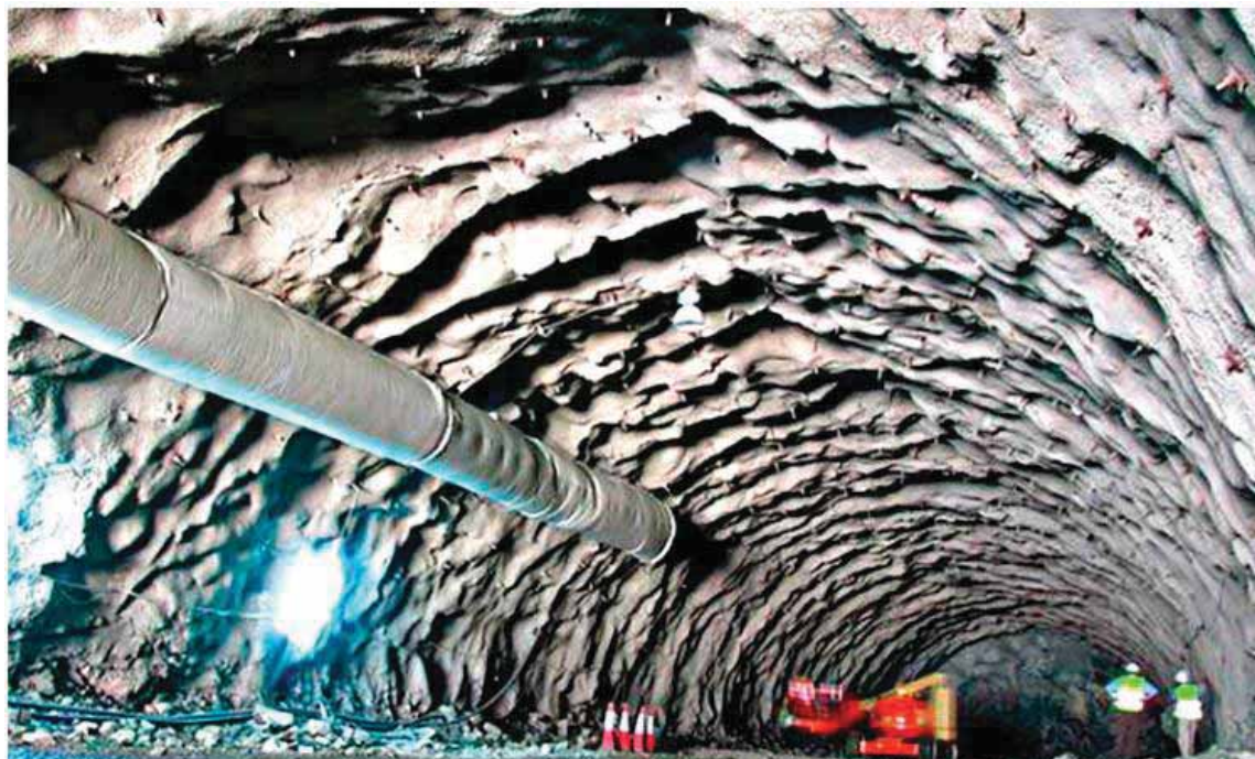
Figura 34: Construcción de túnel Fuente: (LEARN MORE, 2015)
