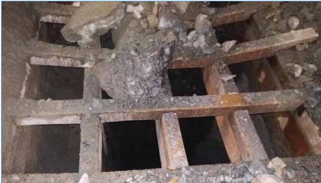
Figura N° 9: Rotura y flexión por la zona de corte y soldadura de la viga.
