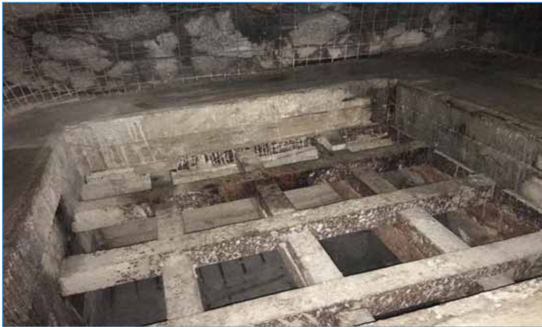
Figura N° 6: instalación de la parrilla mecánica.
