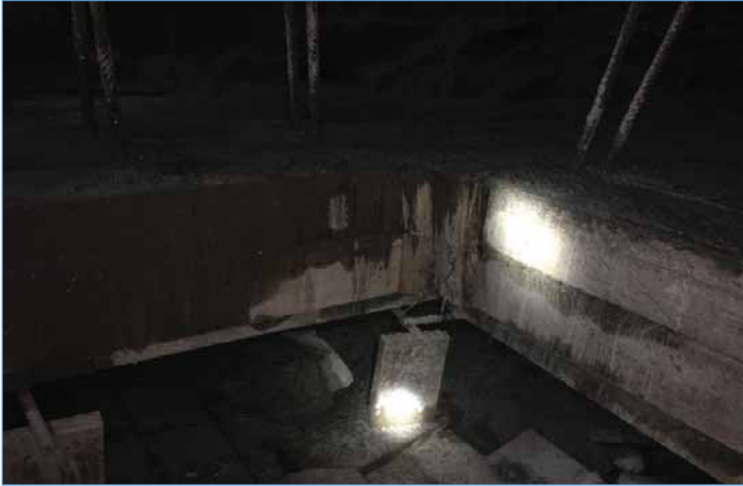
Figura N° 5: Proceso de encofrado de las bases de la parrilla.
