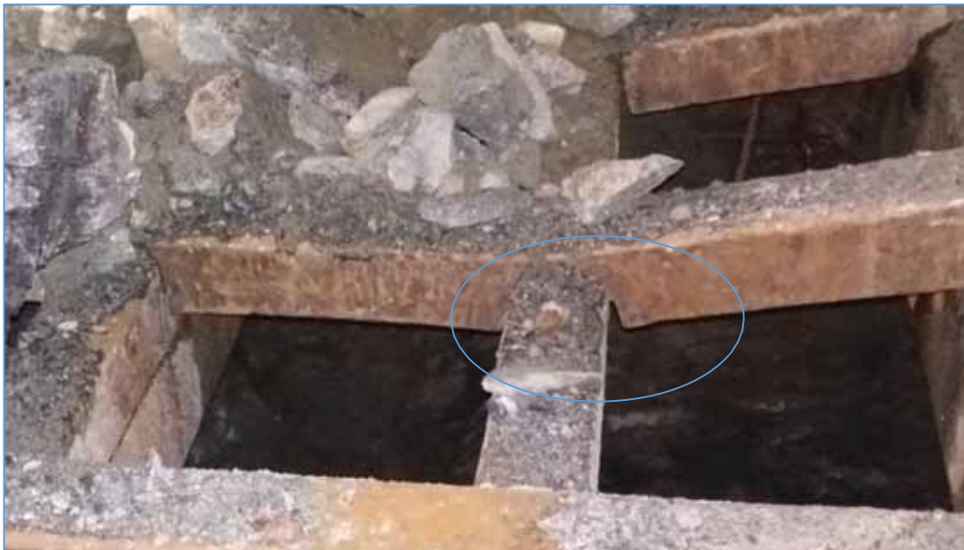
Figura N° 9: Rotura y flexión por la zona de corte y soldadura de la viga.
