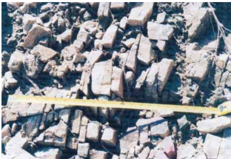
Figura 11. Muestra de fracturas. Fuente: Propia.
