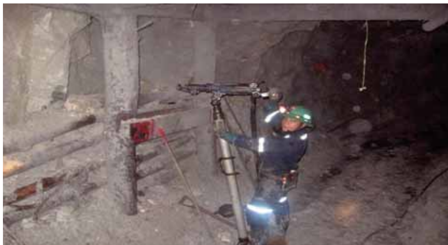
Figura 22. Uso de la Perforado Jack Leg. Fuente: Área de mina – Huarón.
