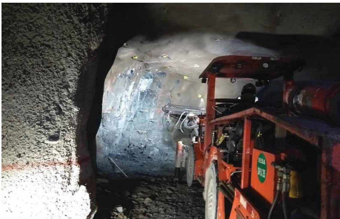
Figura 86 Perforación con Jumbo con marcado de malla y pintado línea centro (dirección de la labor) Fuente: fotografía propia de mina Arcata
