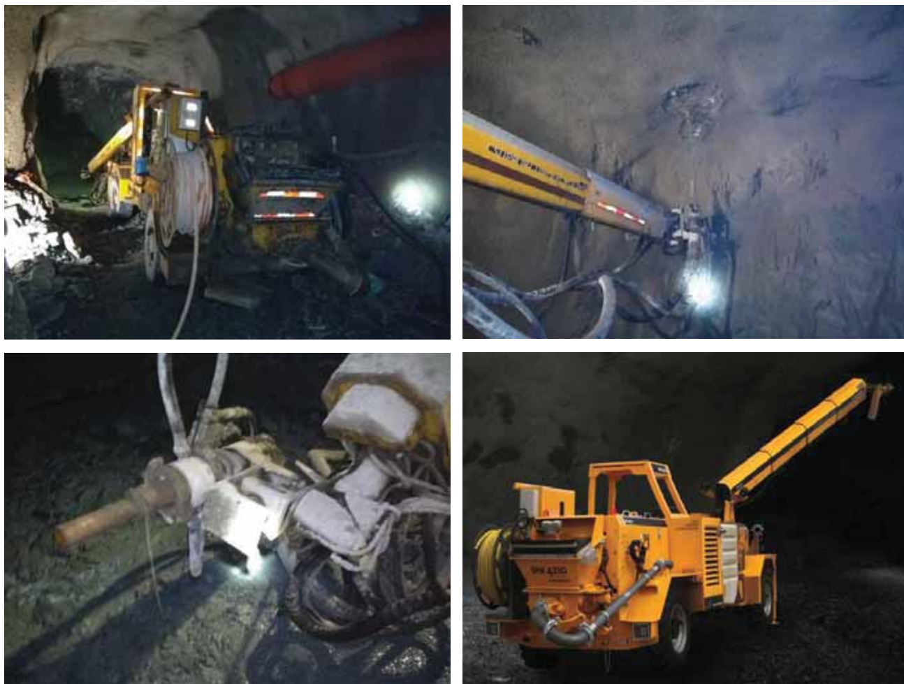
Figura 71 Equipo lanzador de shotcrete - Minera Arcata, Fuente: fotografía propia en mina Arcata
