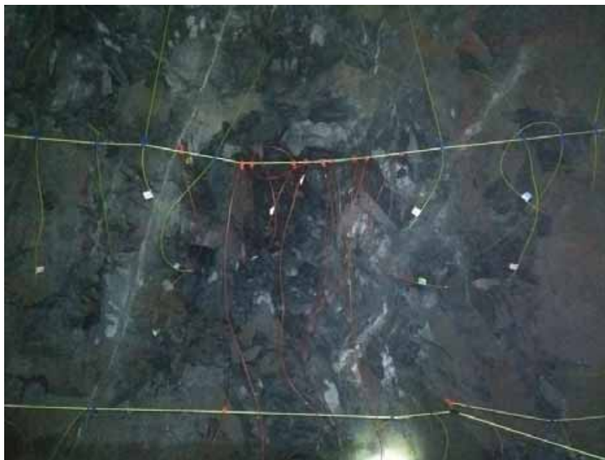
Figura 84. Amarre de fanel con el cordón detonante, Fuente: fotografía propia de mina Arcata
