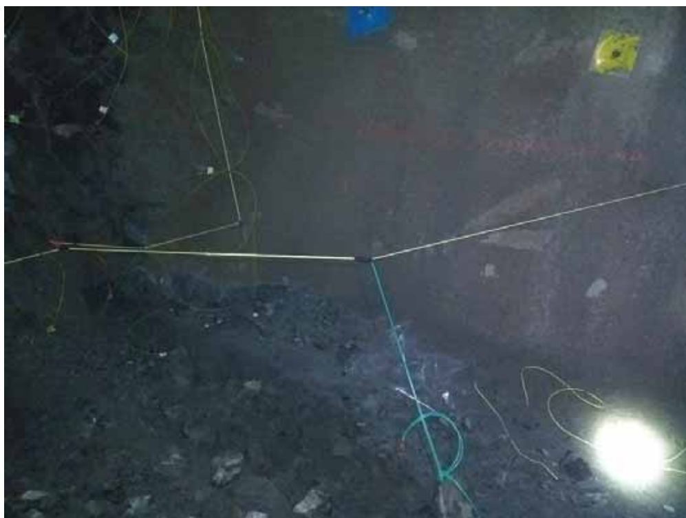
Figura 85. El amarre con el Sistema Carmex al Cordón Detonante para dar el inicio de voladura Fuente: fotografía propia de mina Arcata
