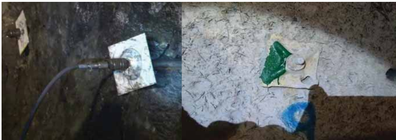
Figura 63 Instalacion de un perno Hydrabolt. Fuente: fotografía propia en mina Arcata
