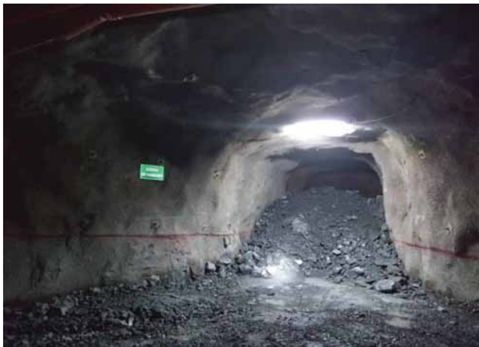
Figura 70 Camara de carguío y acumulación sostenido con shotcrete y perno hydrabolt sistematico-Minera Arcata, Fuente: fotografía propia en mina Arcata
