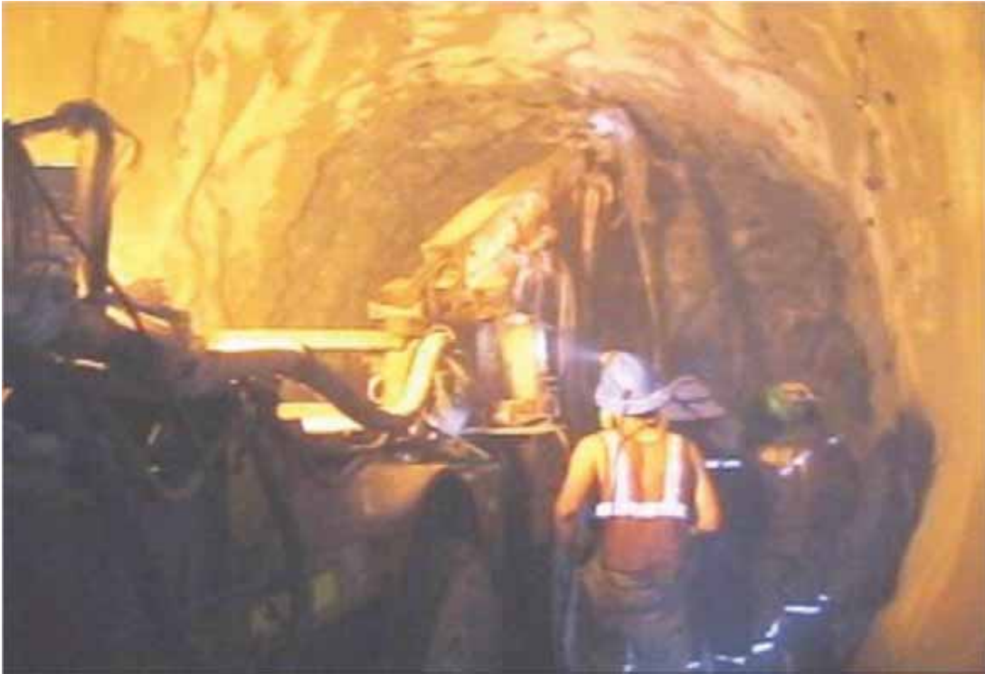
FIGURA 22. Lanzado de shotcrete
