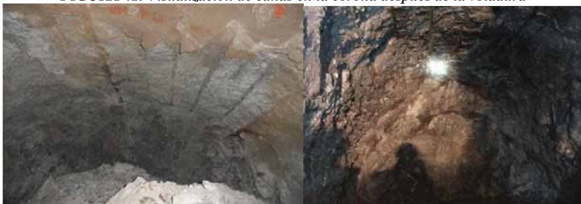
FIGURA 41. Visualización de cañas en la corona después de la voladura
