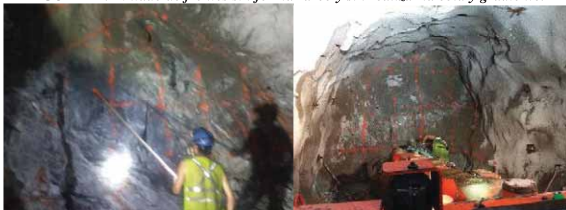
FIGURA 27. Pintado de frentes sin formar arco y sin realizar la cola y gradiente.
