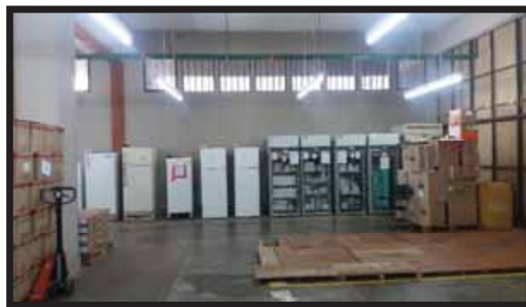
Fotografía 8: Vista general de la ubicación de los equipos de refrigeración en el Almacén Especializado
