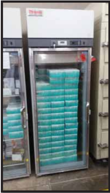
Fotografía 13: Sobrecarga de medicamentos en los equipos de refrigeración
