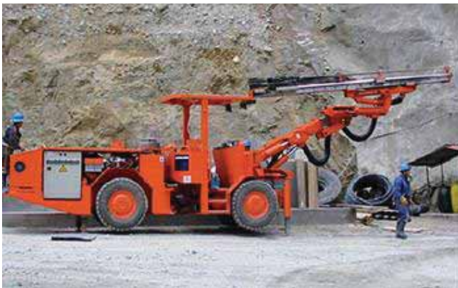
Figura 14. Perforación mecanizada con Jumbo electrohídrico
