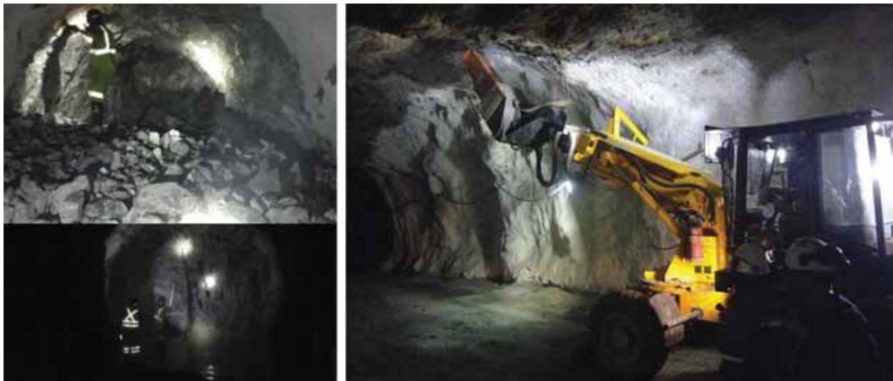
Figura 4. Desate de rocas manual y mecanizado Fuente: Propia
