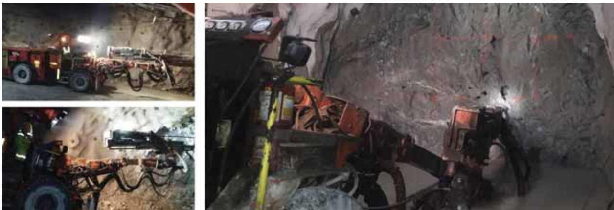
Figura 3. Perforación con jumbo electrohidráulico (modelo Axera)
