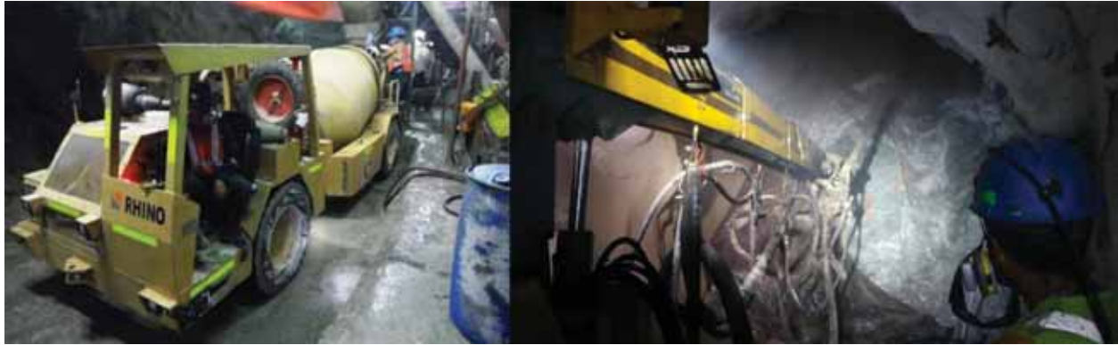
Figura 7. Sostenimiento con shotcrete vía húmeda (abastecimiento con mixer y robot lanzador)
