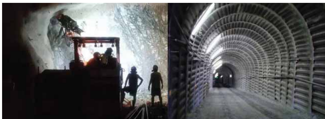
Figura 8. Sostenimiento con pernos a compresión (bolter) y cimbras metálicas Fuente: Propia
