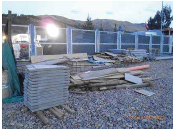
**Figura 26. Disposición de RS peligrosos de forma inapropiada.**
