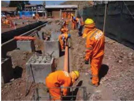
El procedimiento para la construcción de los colectores es el siguiente: Se coloca una cama de apoyo de 12 cm. de espesor de arena gruesa, luego se procedió a alinear y verificar la pendiente de la tubería, realizado esto se procede a colocar el material selecto de relleno de 20 cm. de espesor sobre la clave del tubo.
