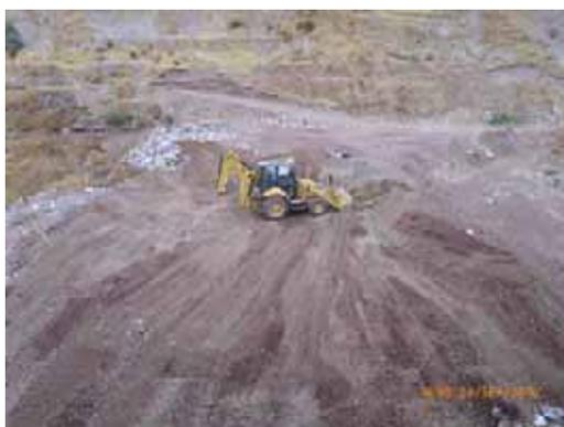
**Figura 58. Limpieza de residuos sólidos en relleno sanitario.**
