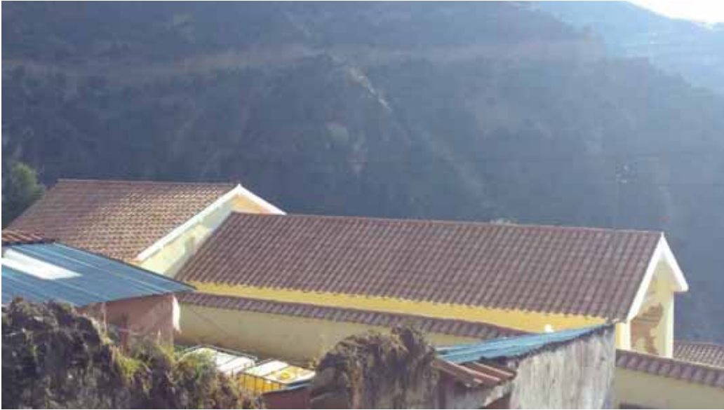
FOTO: N° 41 Vista de la cobertura (exterior).
