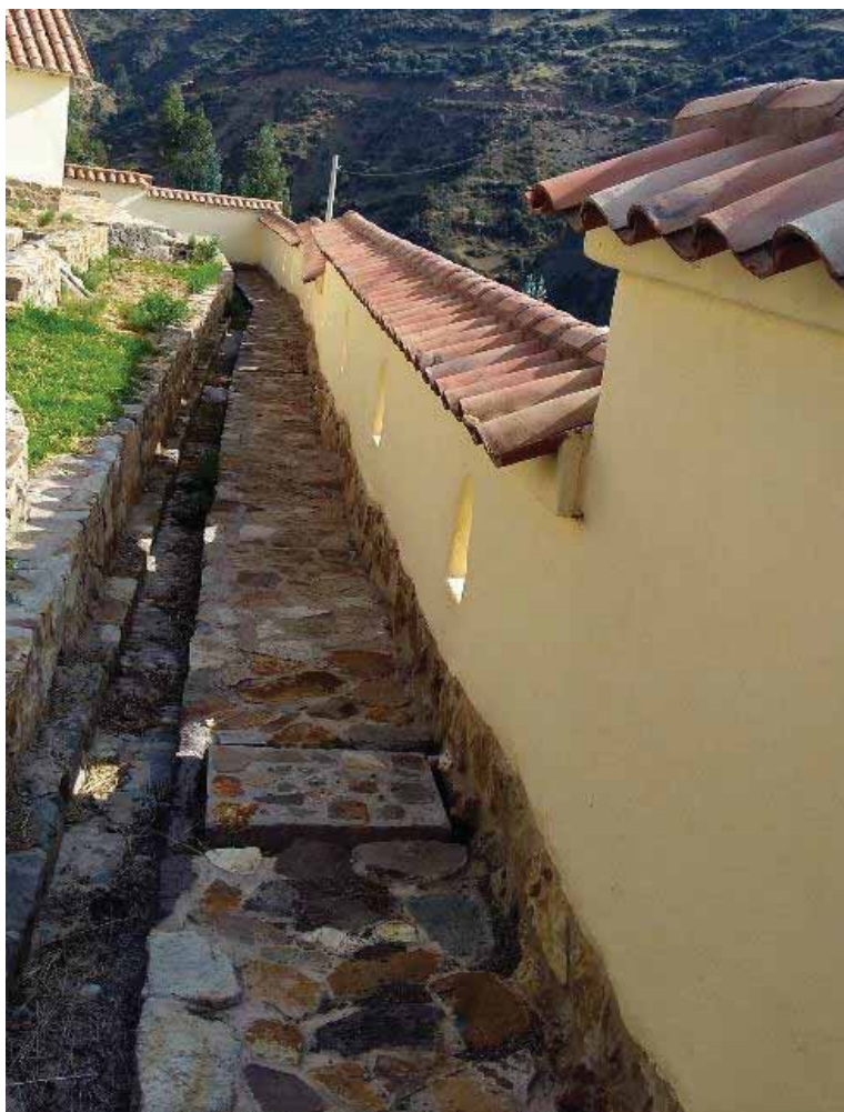
FOTO: N° 40 Vista del cerco perimetral este.
