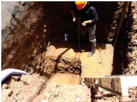
Pozo a Cielo abierto – EMS Urb. Larapa, Calle 4 B-3-12
