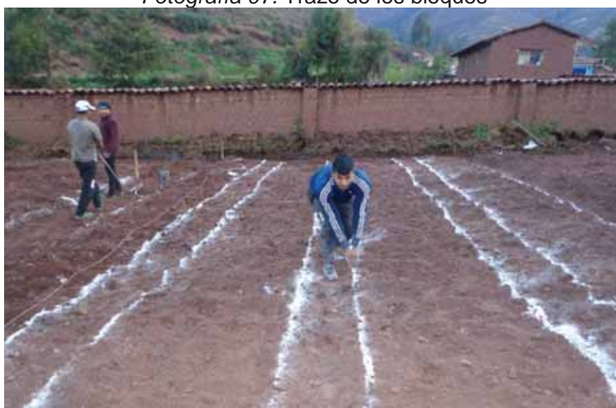
Fotografía 07. Trazo de los bloques
