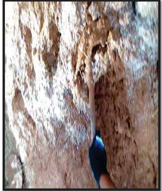
FIGURA103. VOLTEADO DE LA MEZCLA PARA UNIFORMIZAR LA MASA DE BARRO
