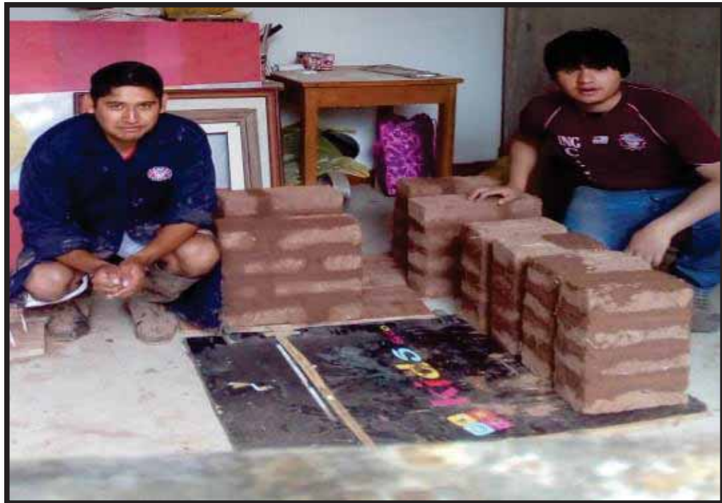
FIGURA 125. ACABADO DE PILAS Y MURETES
