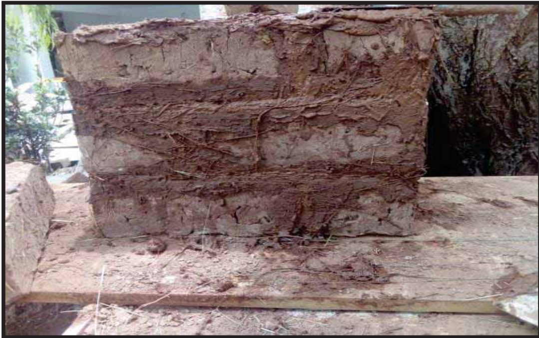
FIGURA 123. COLOCACION DE MORTERO
