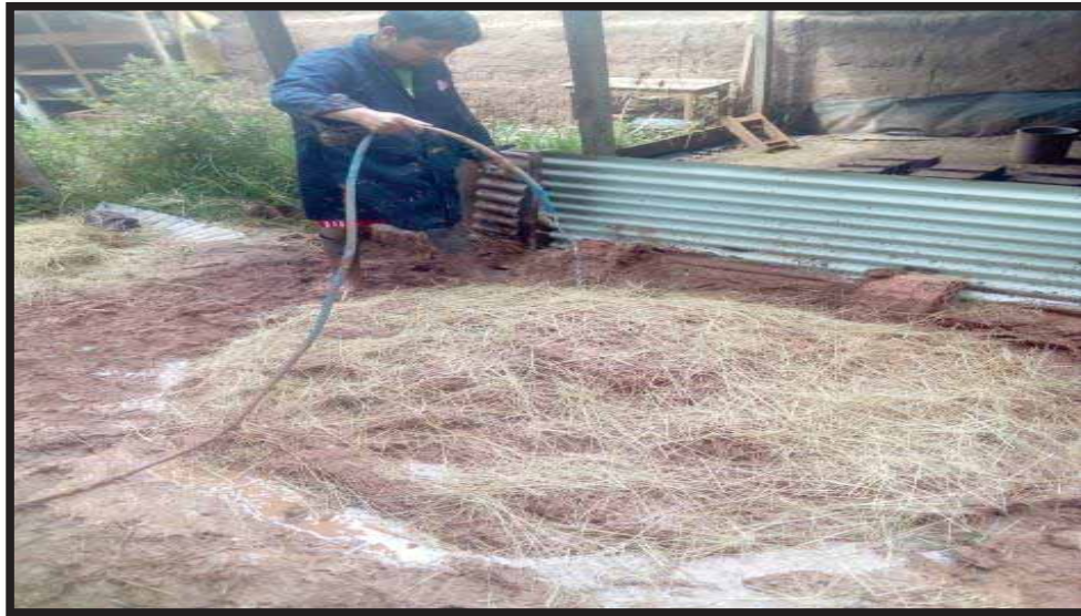
Figura 4. Preparación de la mezcla
