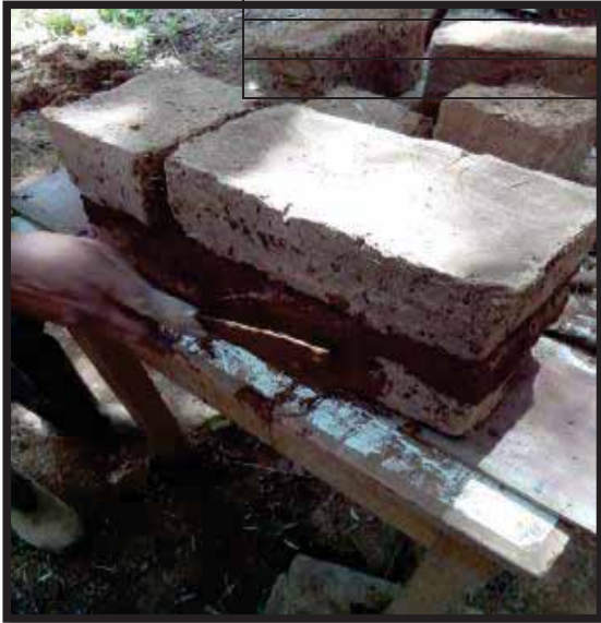
FIGURA 121. ELABORACION DE MURETES
