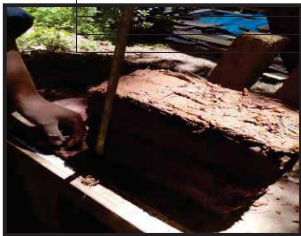
FIGURA 116. CONTROL DE ALTURA EN ELABORACION DE PILAS
