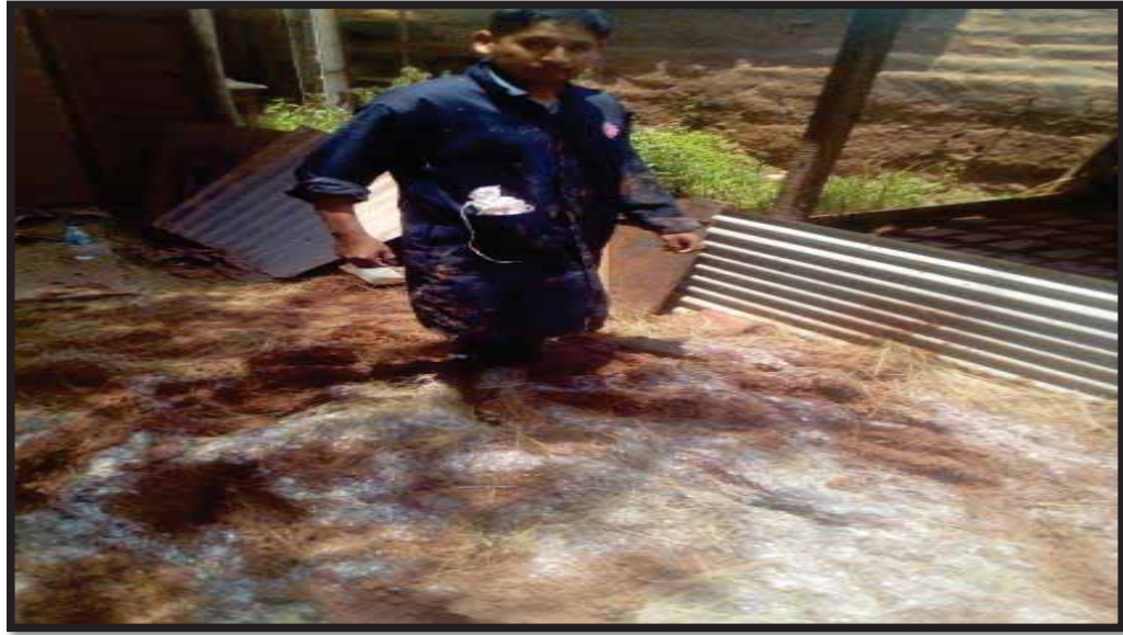
Figura 5a. Mezcla del barro con adición de plástico picado al 3% de plástico picado de botellas
