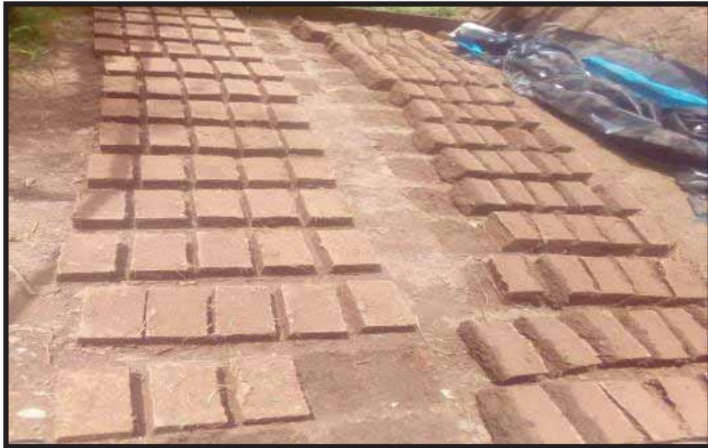
FIGURA 109. VOLTEADO DE LAS UNIDADES DE ADOBE PARA UN MEJOR SECADO
