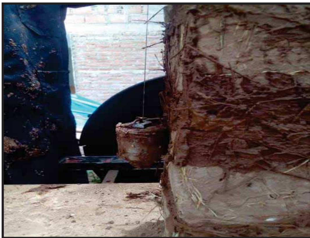
FIGURA 118. CONTROL DE VERTICALIDAD DE LA PILA CON PLOMADA
