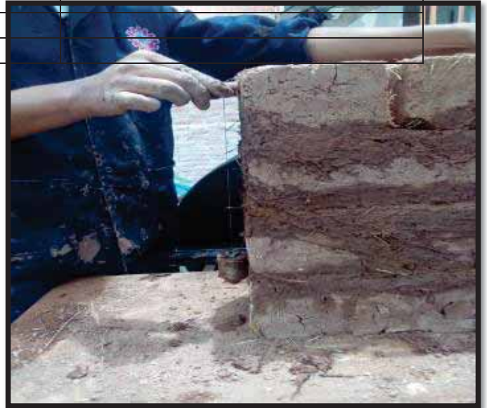
FIGURA 122. CONTROL DE VERTICALIDAD DEL MURETE CON PLOMADA
