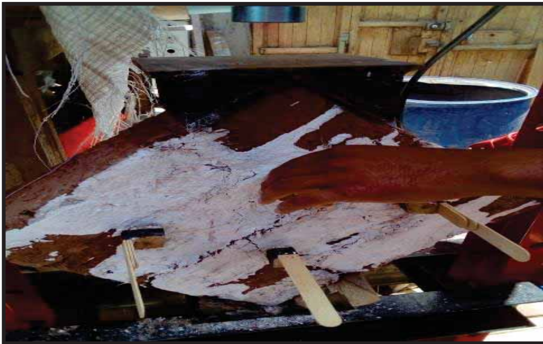
FIGURA 135. COLOCACION DE TACOS A 20 cm DE DISTANCIA
