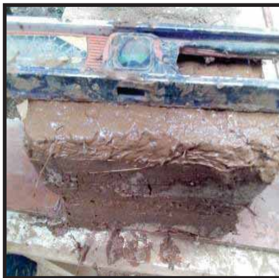
FIGURA 119. NIVELACION DE LA JUNTA CON NIVEL DE MANO
