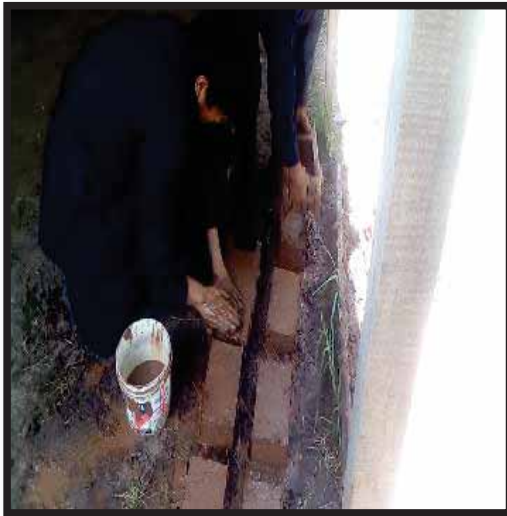
FIGURA 107.ACABADO DE LA CARASUPERIOR DEL ADOBE Y RETIRDO DEL MOLDE
