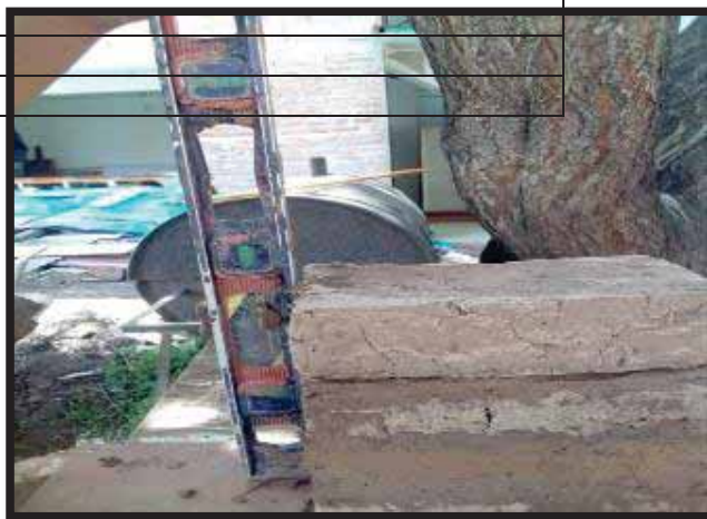
FIGURA 117. NIVELACION VERTICAL EN CARA LATERAL DE LA PILA
