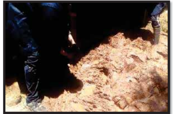
Figura 27 b. Masa de barro para elaboración de adobes
