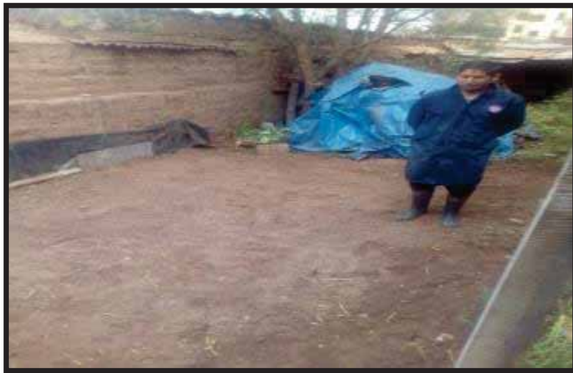
Figura 3. Limpieza del terreno para secado de adobes
