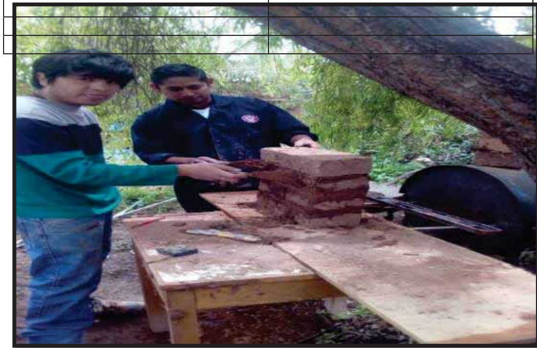
FIGURA 124. PERFILADO DE LAS CARAS DEL MURETE
