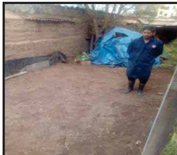
FIGURA 91. TERRENO LIMPIO Y NIVELADO
