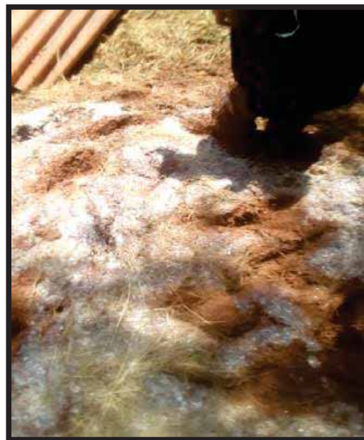
FIGURA 101. PISADO DE LA MEZCLA DE TIERRA, AGUA, PAJAY PLASTICO PICADO DE BOTELLAS
