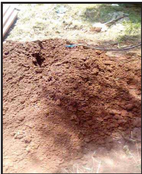
FIGURA 96. DOSIFICACION DE TIERRA PARA ELABORACION DE ADOBES
