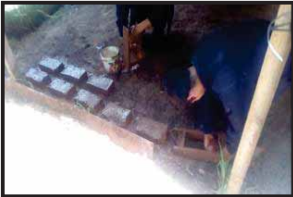
Figura 27 a. Mojado de los moldes de adobe
