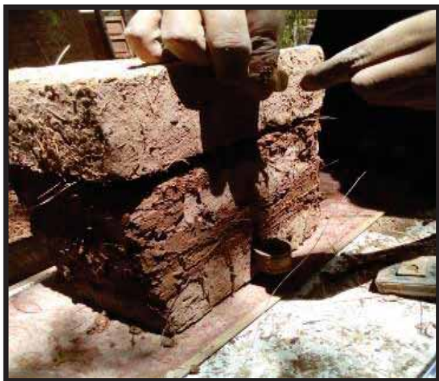
FIGURA 119. NIVELACION CON PLOMADA DE LA PILA
