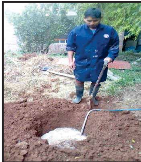
FIGURA 97. ADICION DE AGUA PARA ELABORACION DE BARRO
