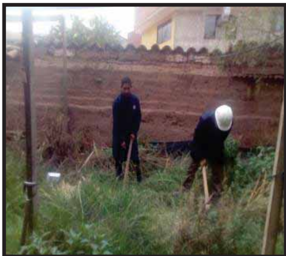
FIGURA 90. LIMPIEZA DEL TERRENO
