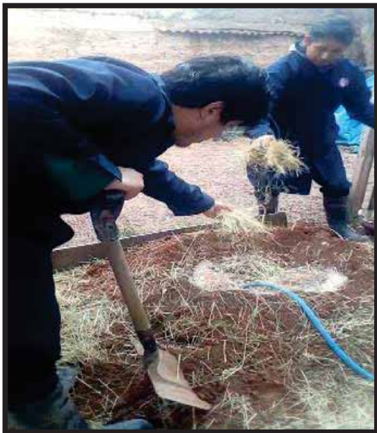
FIGURA 98. MEZCLADO DE TIERRA, PAJA Y AGUA PARA LA ELABORACION DE ADOBES TRADICIONALES
