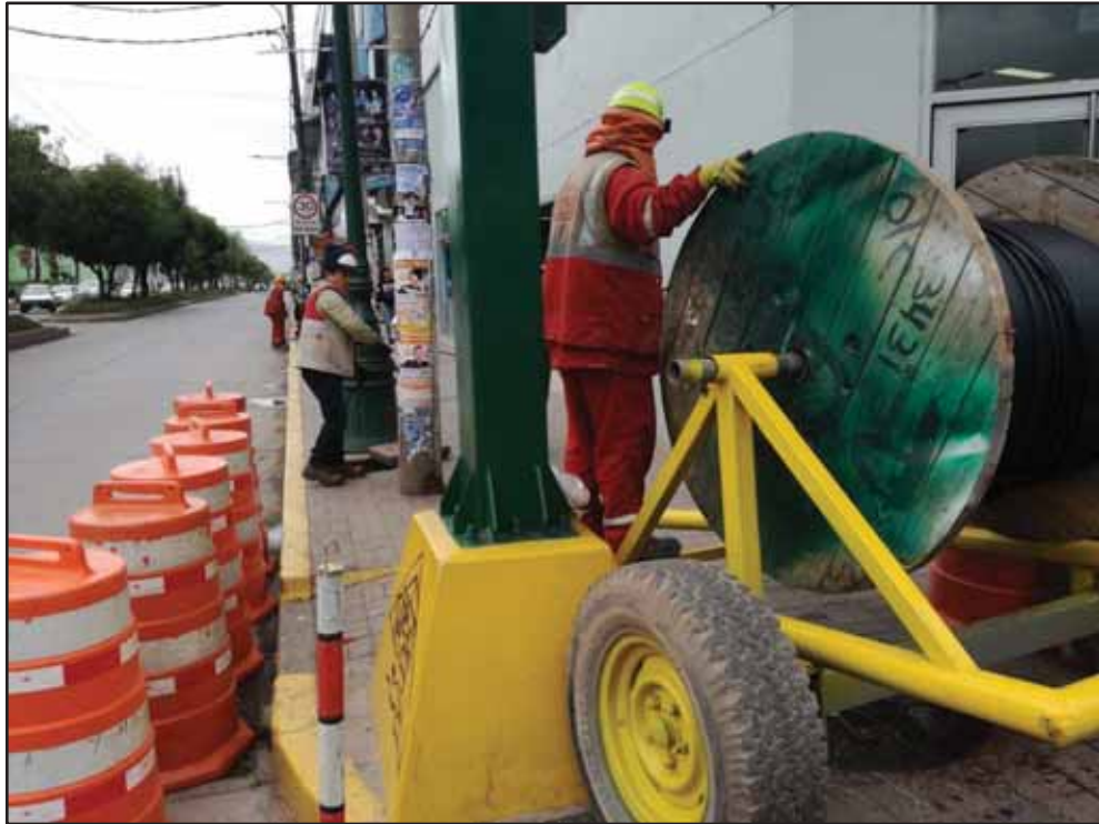
Fig. 7.2 Instalación de Fibra Óptica
