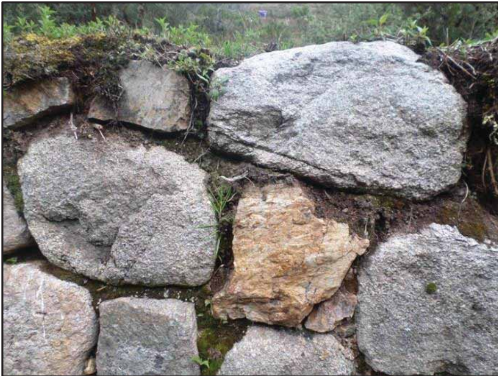
Foto 45. Uso de la tierra como mortero. Sitio Arqueológico de Bateachayoq 2017. Foto de los autores.
