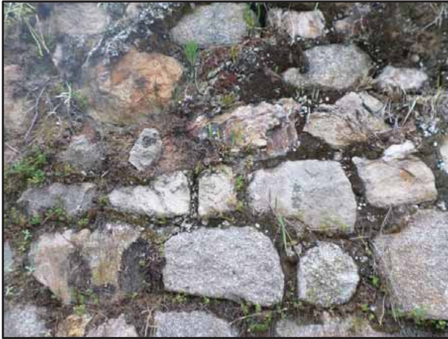
Foto 14. Aparejo engastado y materiales (piedra y argamasa). Sitio Arqueológico de Bateachayoq 2017. Foto de los autores
