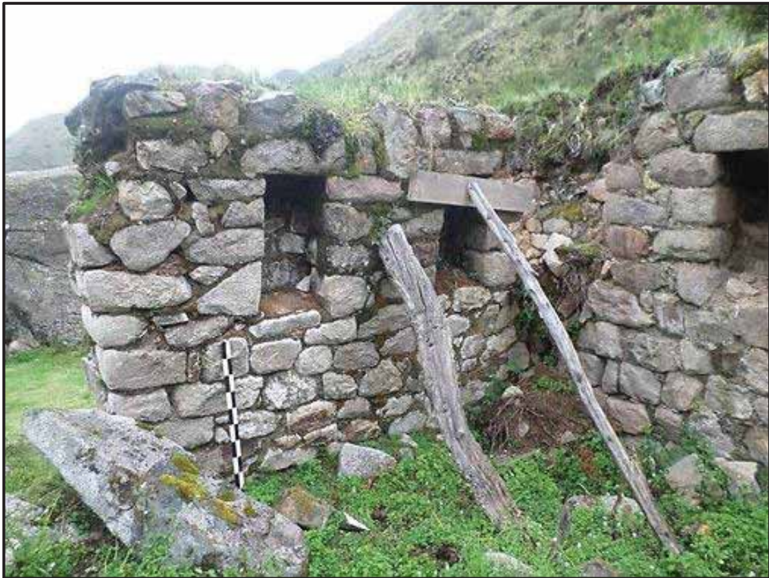
Foto 16. Apuntalamiento de muro. Sitio Arqueológico de Bateachayoq 2017. Foto de los autores.
