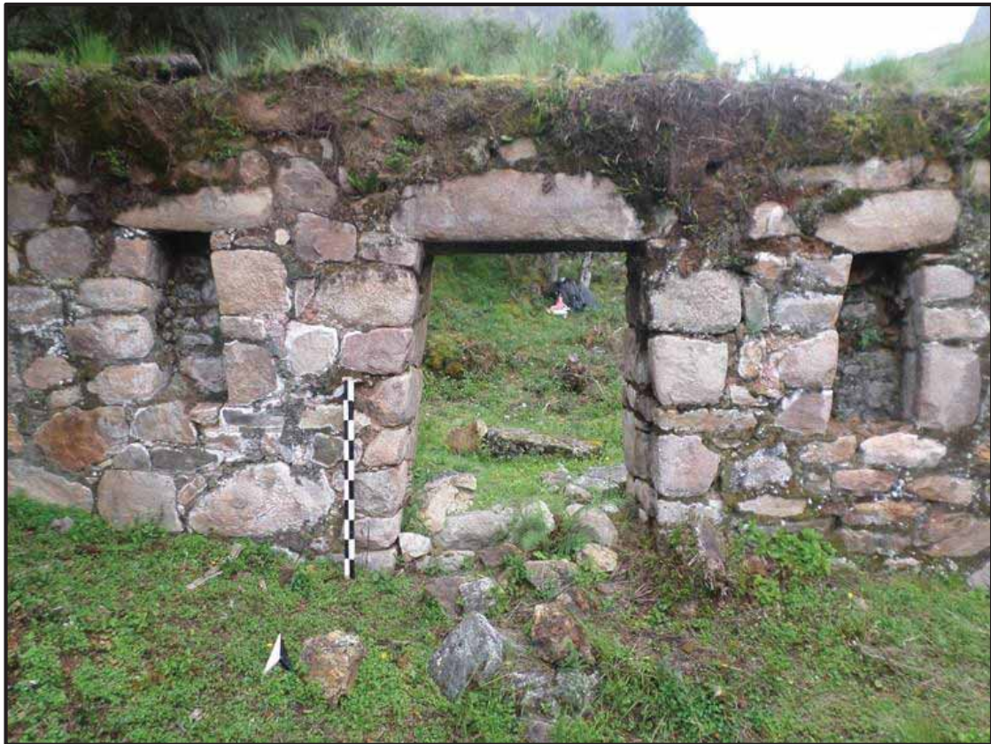
Foto 5. Acabado de jamba (vano de acceso y hornacina). Sitio Arqueológico de Bateachayoq 2017. Foto de los autores
