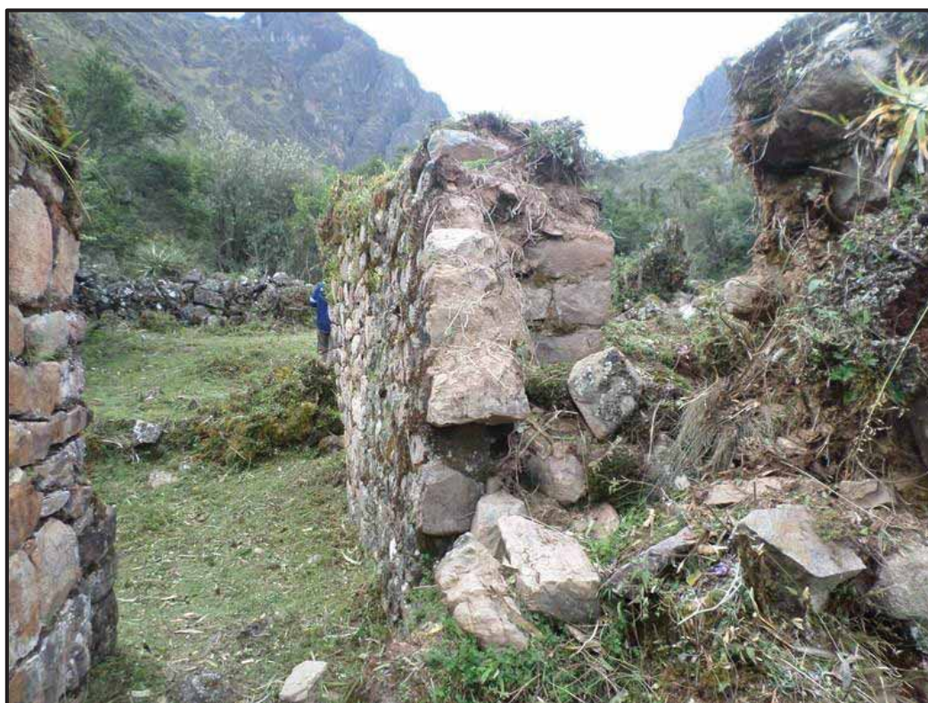
Foto 61. Colapso de muro por el intemperismo ambiental. Sitio Arqueológico de Bateachayoq 2017. Foto de los autores.
