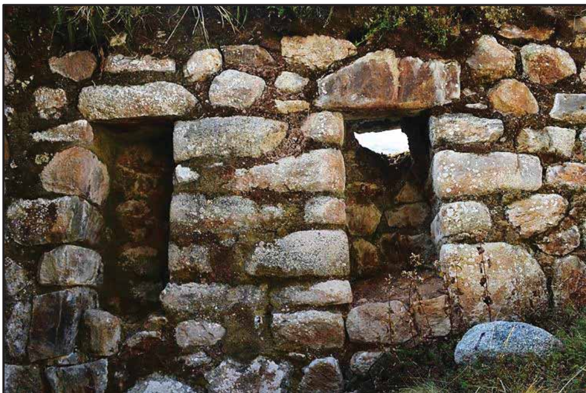
Foto 46. Uso de tierra para emboquillado. Sitio Arqueológico de Bateachayoq 2017. Foto de los autores.
