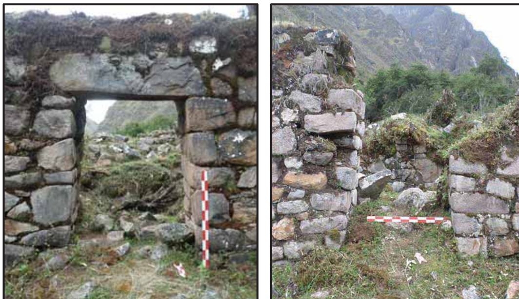
Foto 72. Vanos de acceso del recinto 01 (izquierda) y recinto 02 (derecha).
