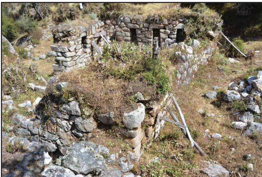
Foto 57. Apuntalamientos en el recinto 02. Sitio Arqueológico de Bateachayoq 2017. Foto de los autores.
