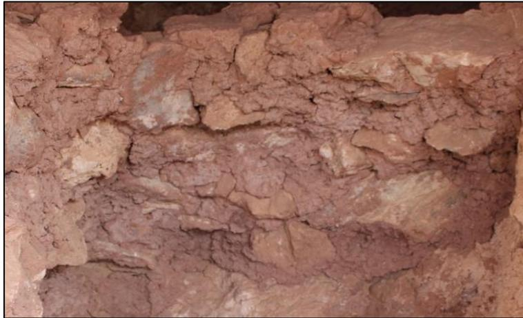
*Foto N° 50: Arcilla utilizada como mortero para el mampuesto de las estructuras funerarias. Fuente: (Marcho Orué, 2018)*
