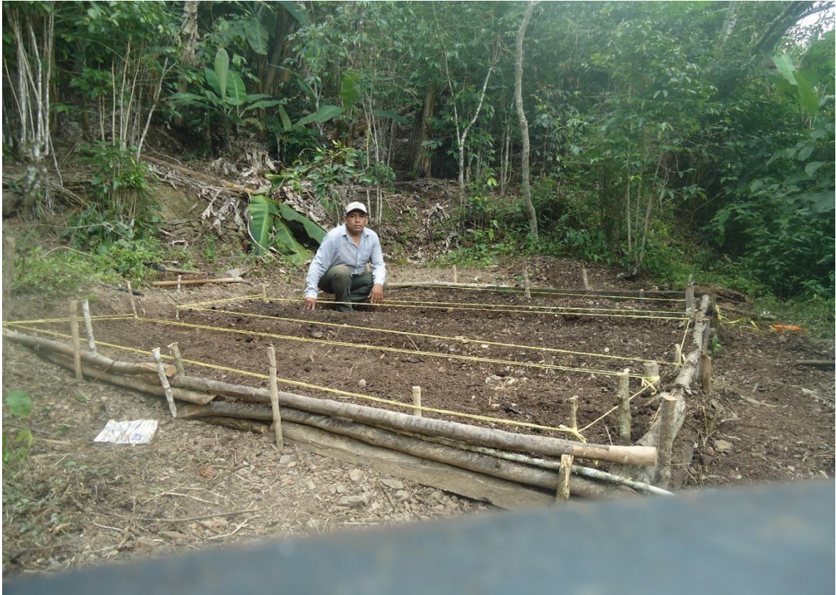
Fotografía N° 12: Construcción de platabandas.
