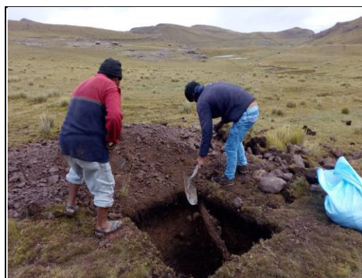
Fot. 10. Trabajo de relleno de material excavado en la calicata una vez retirado la muestra de suelo.
