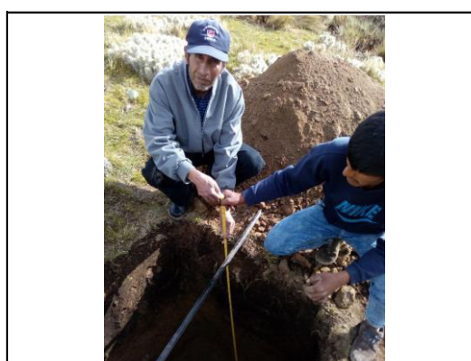
Foto 12. Medición de la profundidad de excavación de la calicata N° 5 en la progresiva del km 03 + 770.
