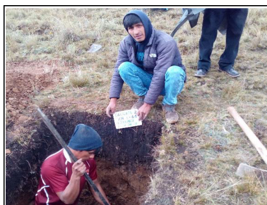
Foto 8. Excavación de la calicata N° 2 en el Km 1 + 44.
