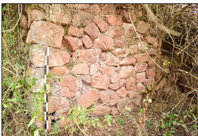
Fotografía N° 7: Vista externa del muro lateral SE del recinto 03-K. Fuente propia.
