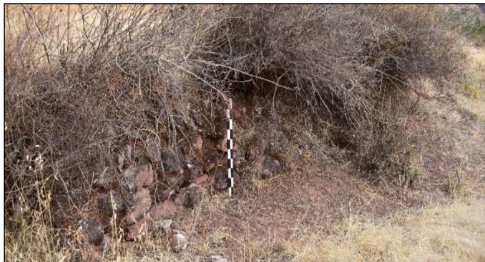
Fotografía N° 294: Vista del muro posterior, adosado al talud natural en forma ovalada. Fuente propia.
