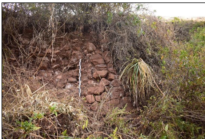
Fotografía N° 9: Vista general del recinto 06-K, se aprecia parte de los elementos líticos que conforman la estructura. Fuente propia.
