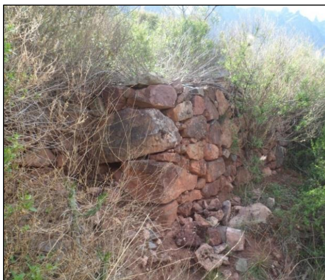
Fotografía N° 82: Vista del muro anterior y lateral del recinto 09-W. Fuente propia.
