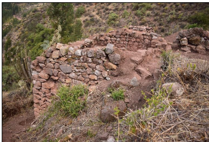
Fotografía N° 21: Vista del muro lateral externo de la estructura 05-K. Fuente propia.
