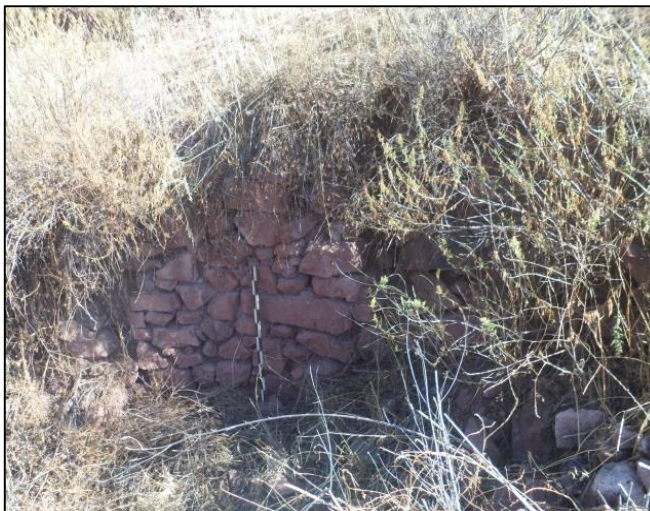
Fotografía N° 52: Vista del lado Norte del muro posterior del recinto 07-W, donde se evidencia el muro curvo. Fuente propia.
