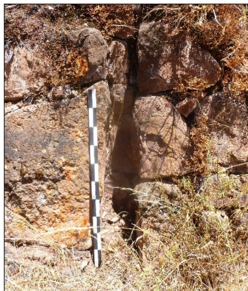
Fotografía N° 23: Vista de canal vertical adosado al andén N° 10. Fuente propia.
