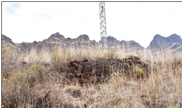
Fotografía N° 28: Vista de Este a Oeste, del muro de contención de la plataforma circular. Fuente propia.
