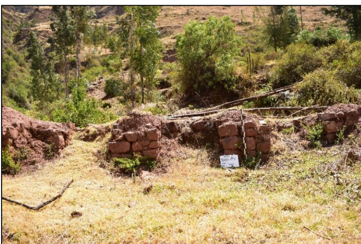
Fotografía N° 14: Vista interna del Recinto 01-K, donde se aprecian los nichos de las caras internas de los muros. Fuente propia.
