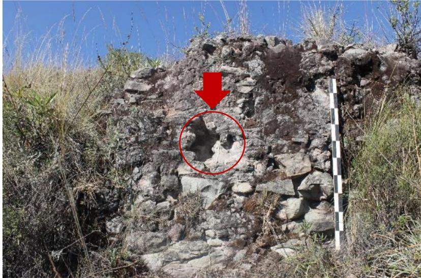
*Imagen 51: Pulverización de los elementos líticos, efecto de factores biológicos como las fuertes lluvias, vientos y radiación solar. Foto: TESISITA*
