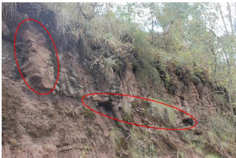
Imagen 44: Perdida de verticalidad de muros de andén. Foto: TESISTA
