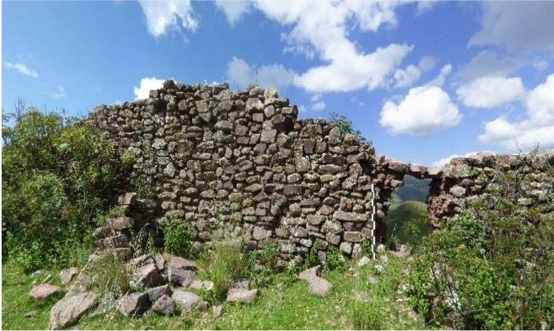
*Imagen 107: Muro de aparejo rústico irregular, conservando alturas mayores de 2.00 m. Foto: TESISTA*
