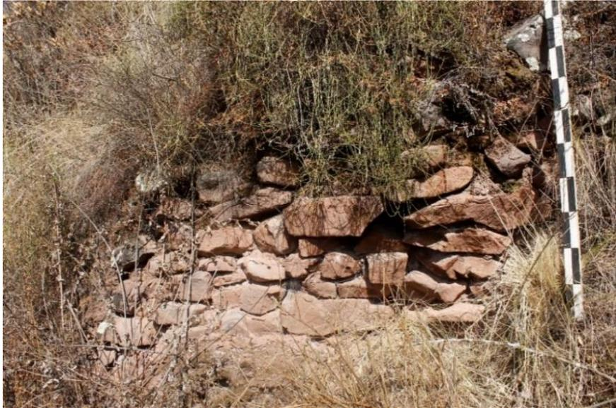
*Imagen 31: Aparejo rústico del muro del andén AQ- 02, en mal estado de conservación. Foto: TESISTA*
