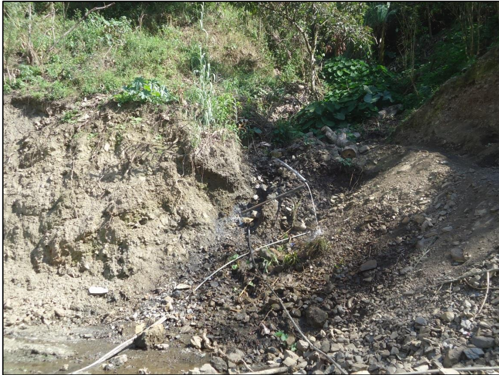
Foto N° 18. Colmatación de quebradas. (W. Atachi R. / A. Hacha S.)
