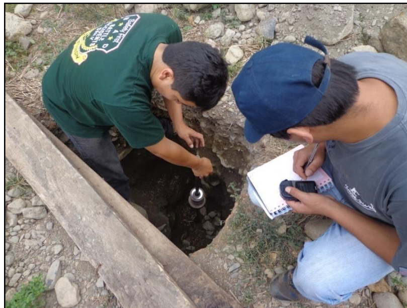
Foto N° 11. Calicata Ca 2 muestreo y pruebas de auscultación PDL en suelos cuaternarios coluviales. (W. Atachi R. / A. Hacha S.)
