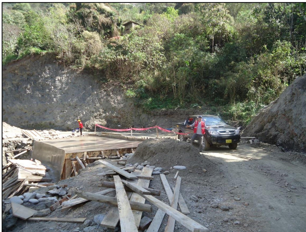
Foto N° 8. Construcción de alcantarilla, para la evacuación de las aguas de quebrada. (W. Atachi R. / A. Hacha S.)
