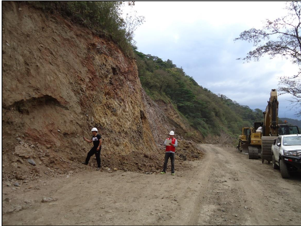
Foto N° 15. Perfilado de Corte de talud con la excavadora. (W. Atauchí R. / A. Hacha S.)
