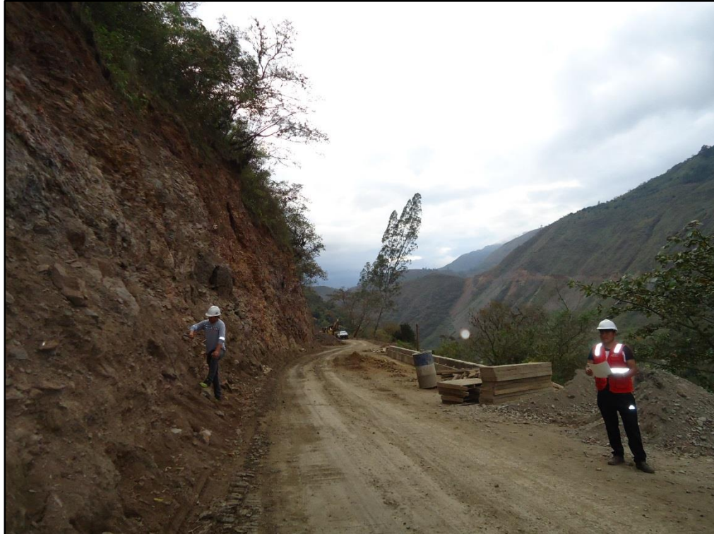
Foto N° 14. Obras de arte. Construcción de muro para el sostenimiento de la plataforma de carretera. (W. Atauchí R. / A. Hacha S.)
