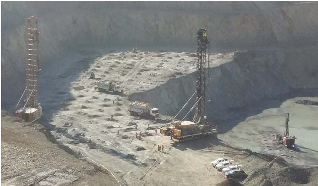
FIGURA N°3.12 Perforadoras primarias 12 ¼" de diámetro de taladro
