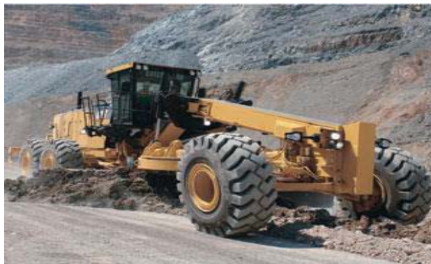
FIGURA N°3.24 Mantenimiento de vías y accesos
