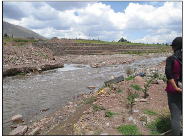
Foto 18: Río Huatanay antes de la PTAR
