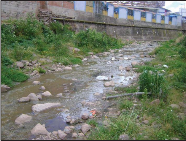
Foto 5: Río Huatanay altura puente Huancaro
