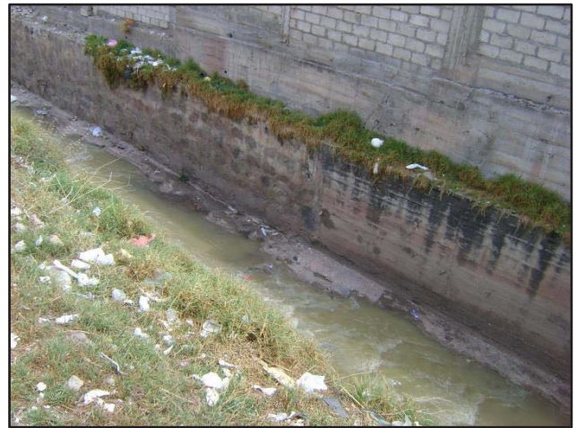
Foto 8: Río Huatanay altura puente Molino I
