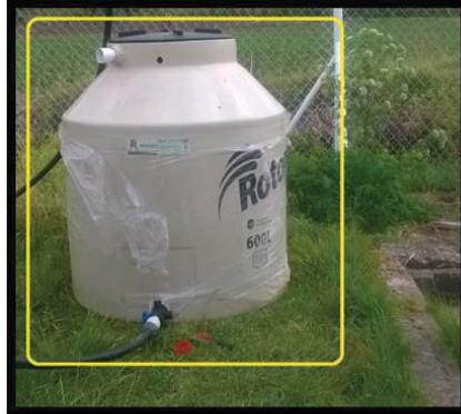
Fotografía 14. Tanque de almacenamiento de agua de 600L
