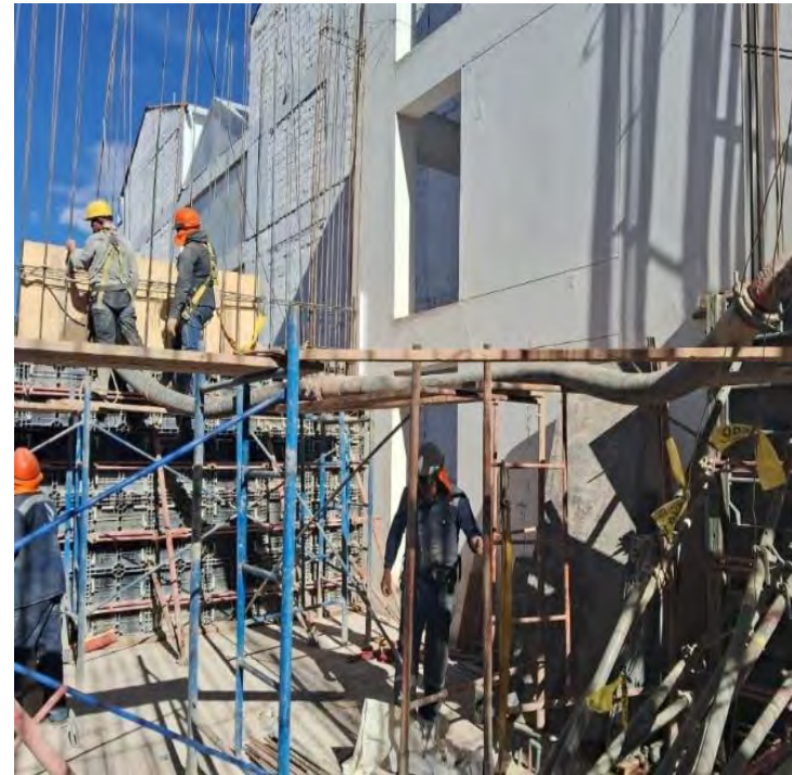
El personal laborando de la empresa, en pleno desarrollo de sus servicios donde se aprecia a trabajadores y el mixer
