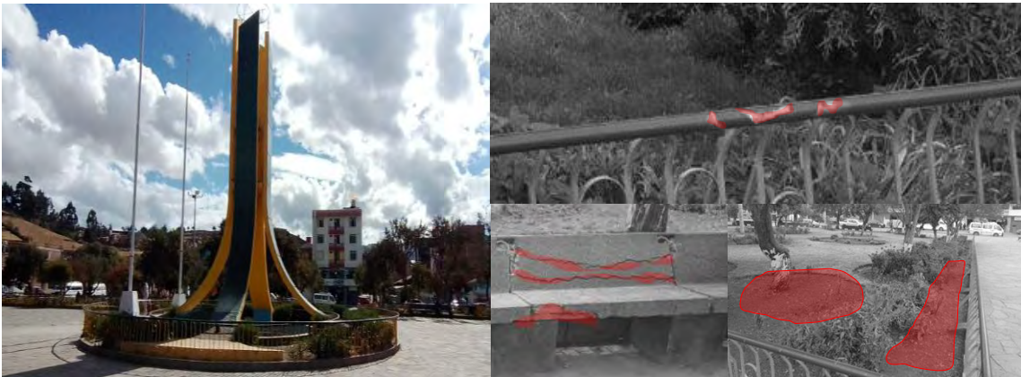
Figura 55 Deterioro ambiental y mecánico en el mobiliario de la plaza cívica
