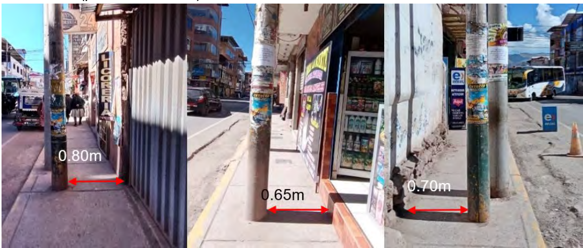
Figura 15 Obstáculos (postes eléctricos)
