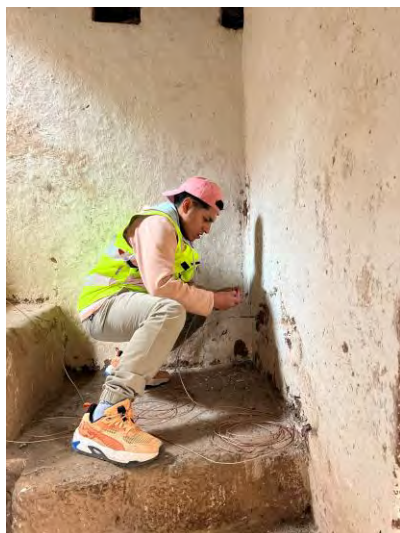
Instalación de Acelerómetros
