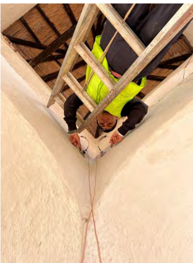
Instalación de sensores
