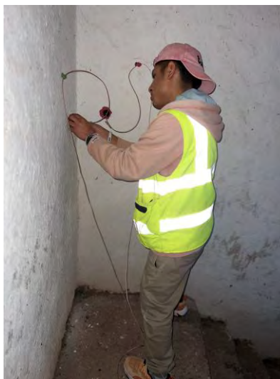
Instalación de Acelerómetros
