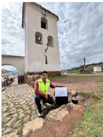
Instalación de Geófono en terreno
