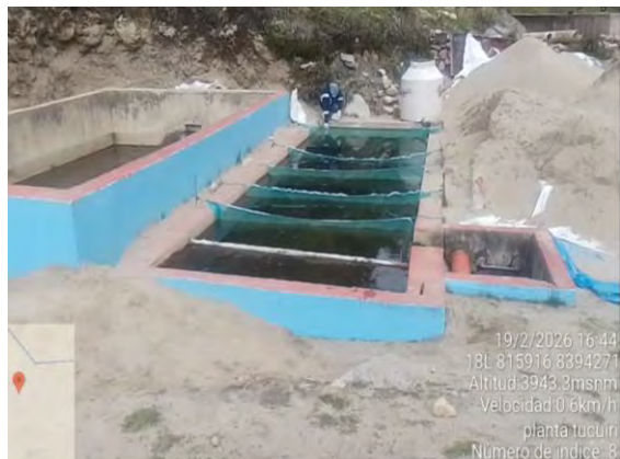
Toma de muestras de agua a ingreso de filtro lento 19/02/2026
