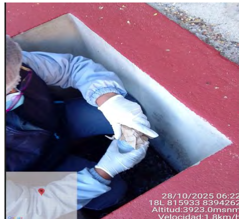
Toma de muestras de agua a ingreso de filtro lento 28/10/2025
