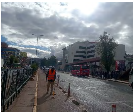
Medición de progresivas y reconocimiento del tramo de estudio mediante el uso de odómetro, para la delimitación e identificación de los subtramos de evaluación.
