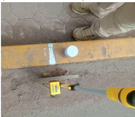
Marcado de progresivas mediante el uso de spray blanco, permitiendo la delimitación y ubicación de los subtramos, así como la identificación precisa de los puntos de medición para la evaluación del IRI, PCI y ahuellamiento del pavimento, además del registro de las concentraciones de CO 2 .
