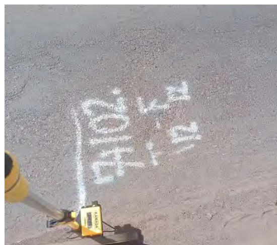
Marcado de progresivas mediante el uso de spray blanco, permitiendo la delimitación y ubicación de los subtramos, así como la identificación precisa de los puntos de medición para la evaluación del IRI, PCI y ahuellamiento del pavimento, además del registro de las concentraciones de CO 2 .
