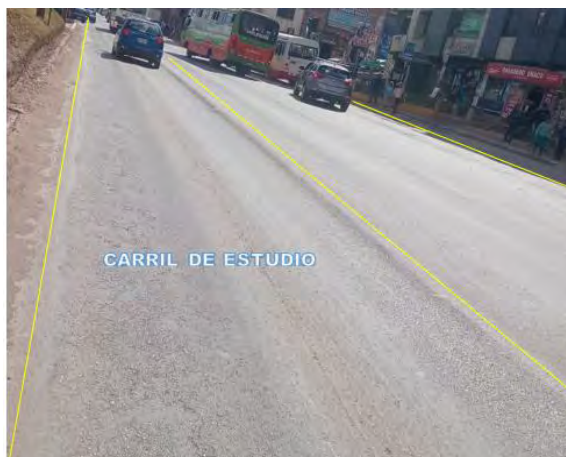
Carril izquierdo de subida del tramo, seleccionado para el estudio de la condición del pavimento y las concentraciones de CO 2 .
