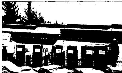
*Figura 20: Bloques de concreto-caucho apilados para su posterior curado.*
