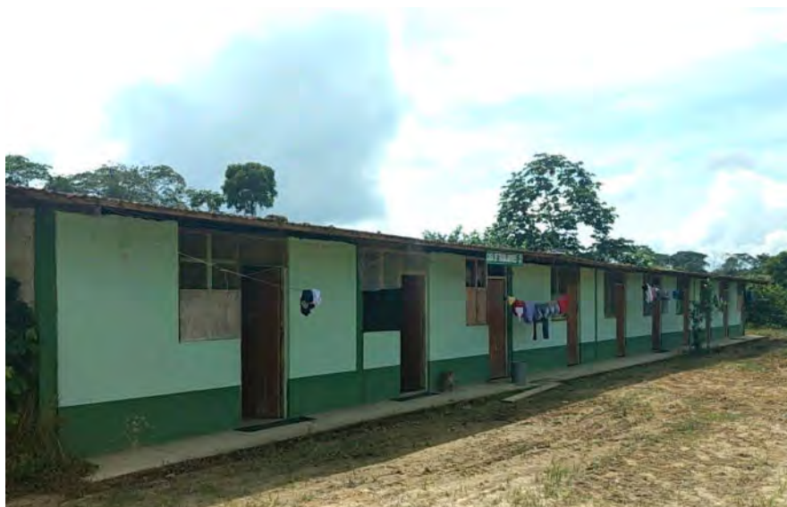
Figura n°15: Vivienda de los trabajadores dentro de la Unidad Minera
