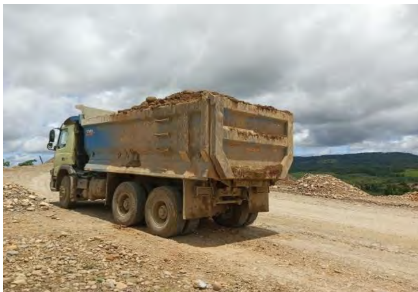
Figura n°9: Acarreo de la grava hacia los chutes
