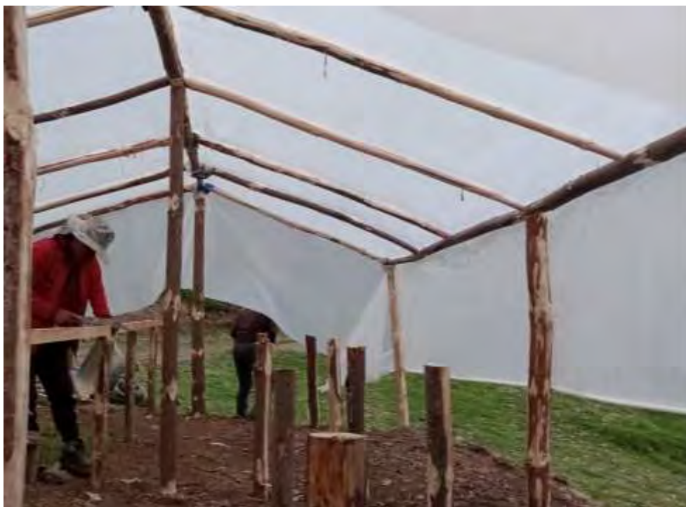
Fotografía 1. Instalación del secadero solar de 4x8m, para el deshidratados del carpóforo.
