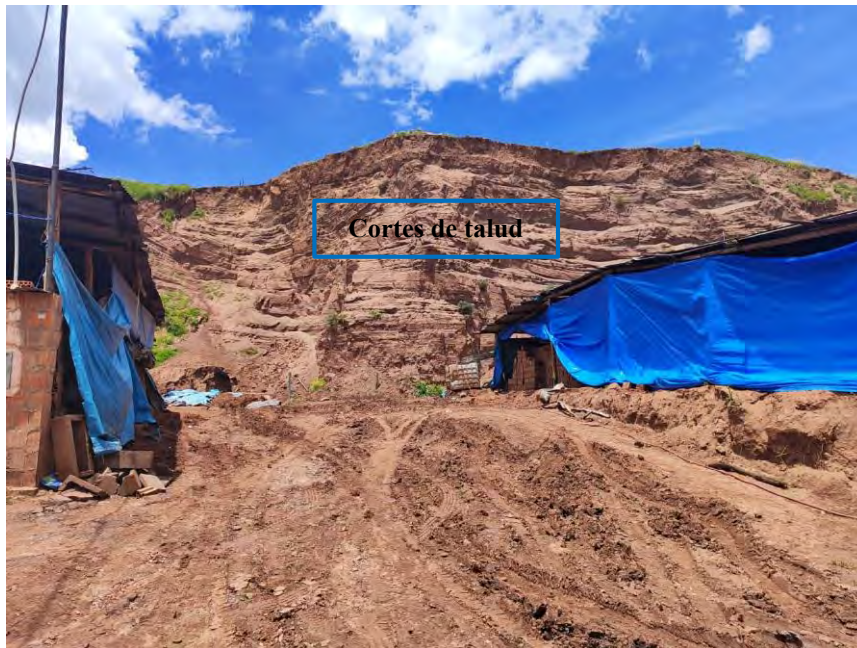
Fotografía 33. Cortes de talud para los hornos de ladrillos
