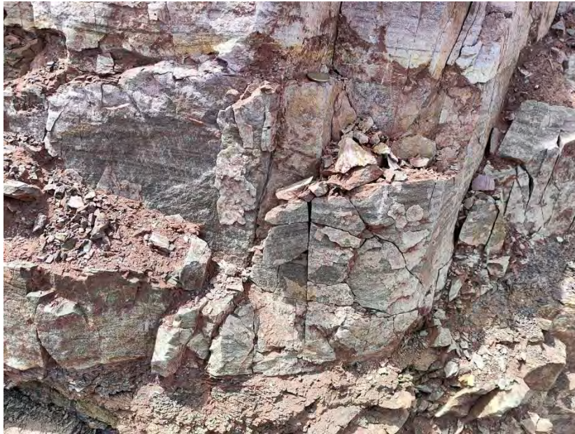
Fotografía 20. Se observa las areniscas feldespáticas que presentan fracturas producto de la meteorización
