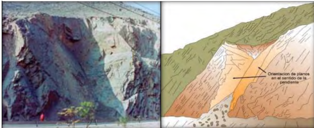
Imagen 6. Deslizamiento en cuña
