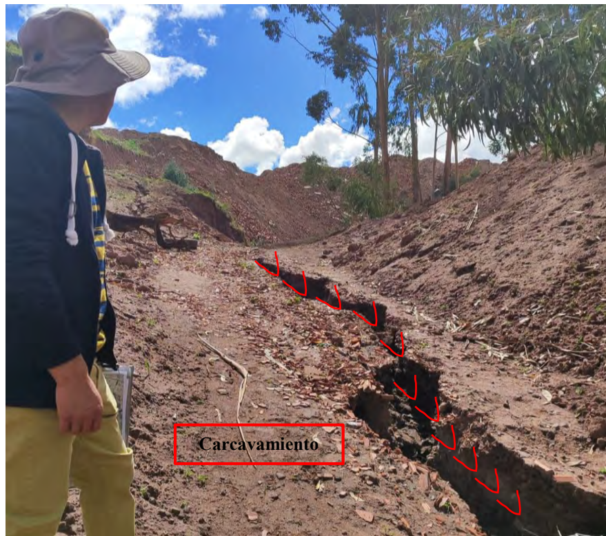
Fotografía 41. Etapa temprana de carcavamiento en la parte media de la quebrada debido a la acción antrópica, se observa también depósitos de desmonte y ladrillos
