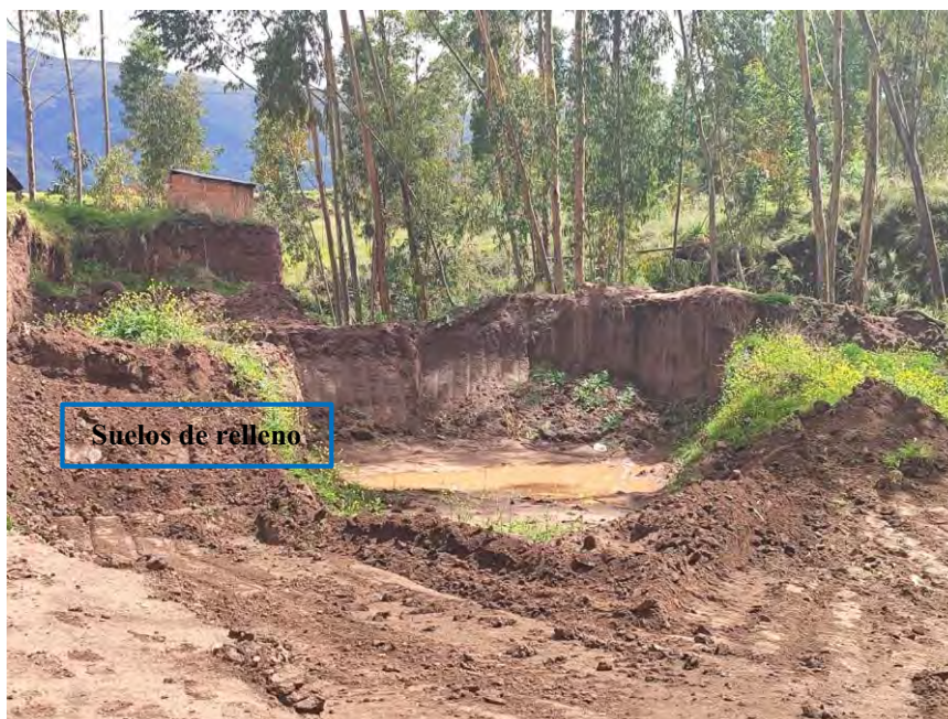
Fotografía 34. Se tiene un corte de talud el cuál será relleno con fin de construcción de viviendas
