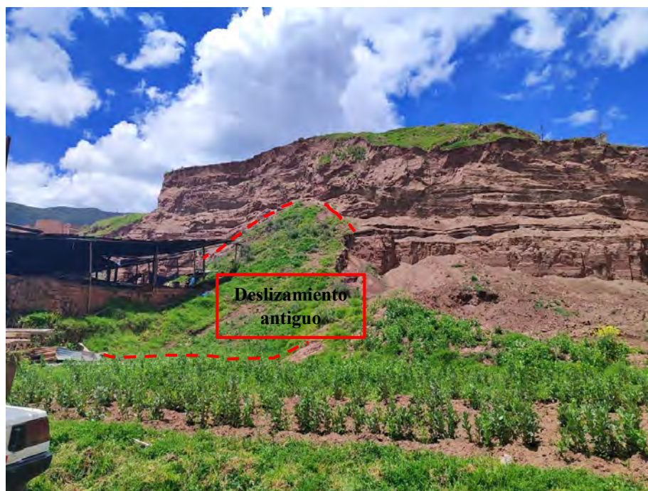
Fotografía 43. Se observa un deslizamiento antiguo que presenta una parte con corte de talud y también con una vivienda al pie del mismo
