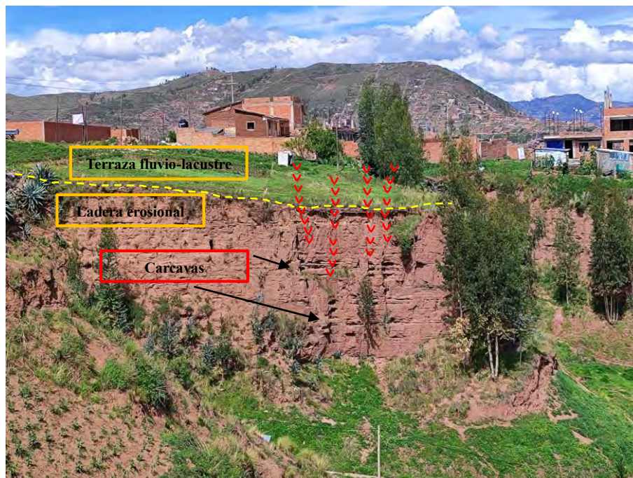
Fotografía 8. Terraza fluvio-lacustre donde se tienen viviendas, podemos observar laderas erosionales al borde junto con los carcavamientos formados por los diferentes tipos de erosión fluvial
