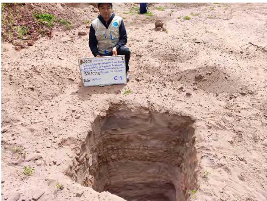
Fotografía 21. Excavación y codificación de la Calicata N° 1 en la Formación San Sebastián.
