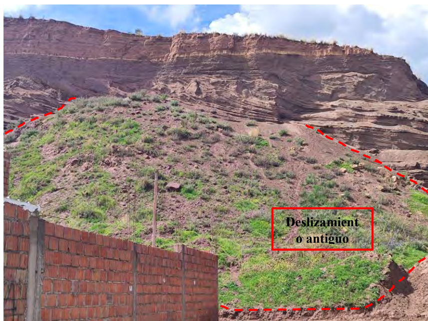
Fotografía 42. Deslizamiento antiguo en la parte baja de la quebrada, se observa que se construye viviendas al pie de este deslizamiento inactivo
