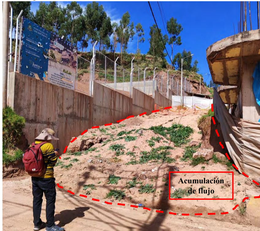
Fotografía 46. Se observa acumulación de flujo en una parte de la carretera en la parte media de la quebrada
