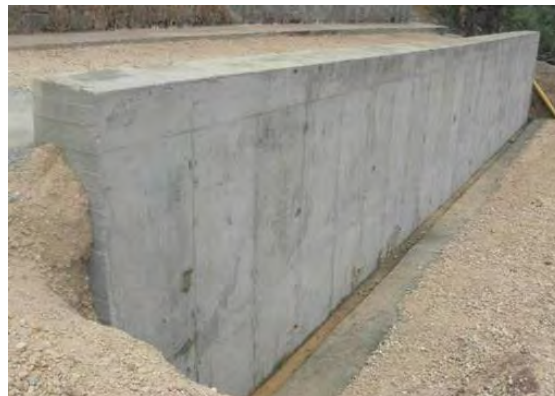
Imagen 16. Muro de contención en carreteras
