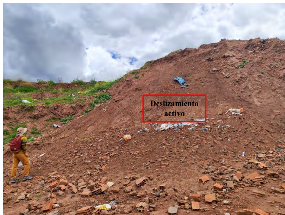
Fotografía 45. Deslizamiento activo producto de la deposición de desmonte y ladrillos
