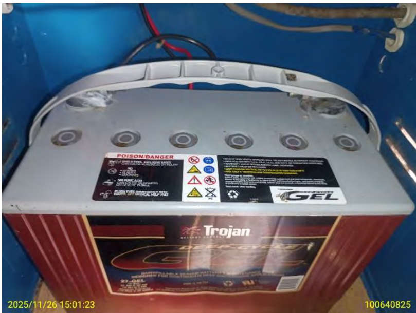
Batería Trojan 27-GEL (12 Vdc, 91 Ah/C20)
