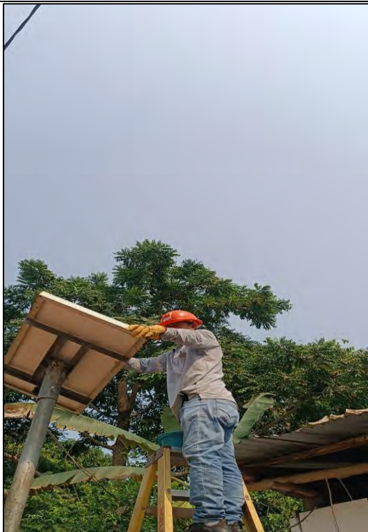
3. Reemplazo de controlador de 40 A
