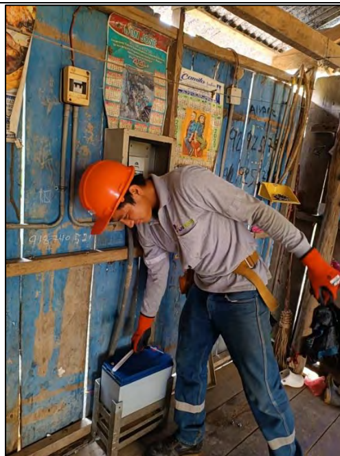
4. Reemplazo de Batería de 90 – 100 Ah
