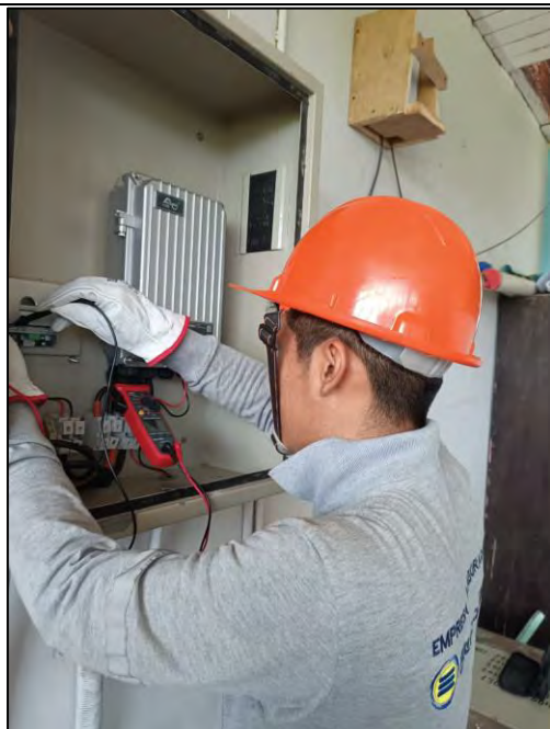
3. Reemplazo de controlador de 40 A
