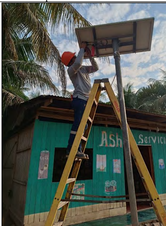
Inspección Minuciosa de la Batería
